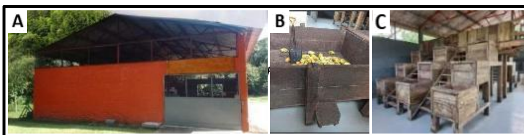
Figura 5. Área de fermentación. (A) Instalación; (B) cajón de selección y (C) cajones fermentadores.
