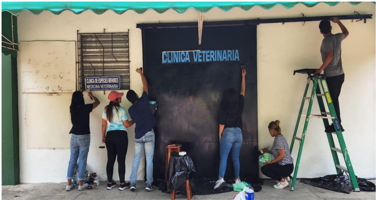
Anexo 28. Restauración de pintura y elaboración de nuevos afiches informativos
