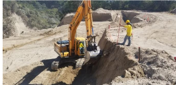
Trabajos de cortes de terraza.
