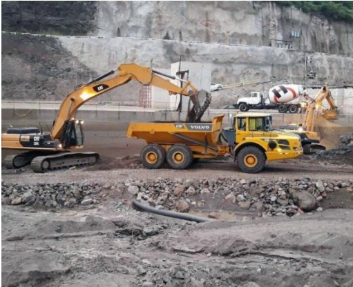
Trabajos de cortes de terraza.
