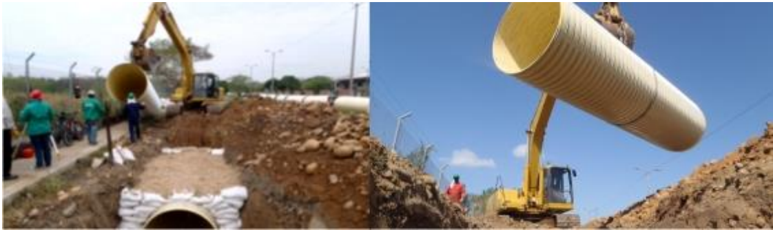
Figura 6. Suministro e instalación tubería
