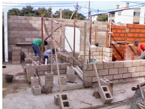
Figura 5. Elaboración de pared de bloque
