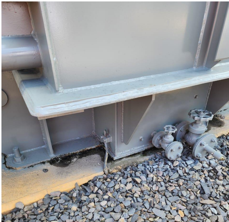
Figura 4.58. Puesta a tierra del chasis de un transformador de potencia
