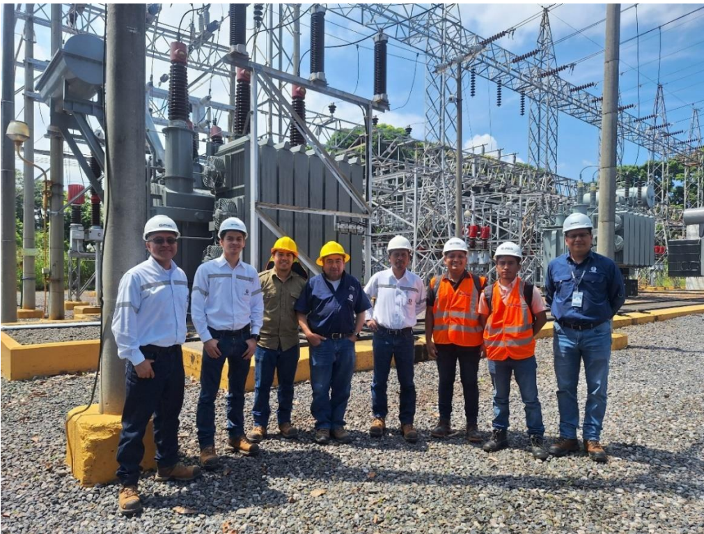
Figura 4.67. Visita técnica Subestación Soyapango-ETESAL
