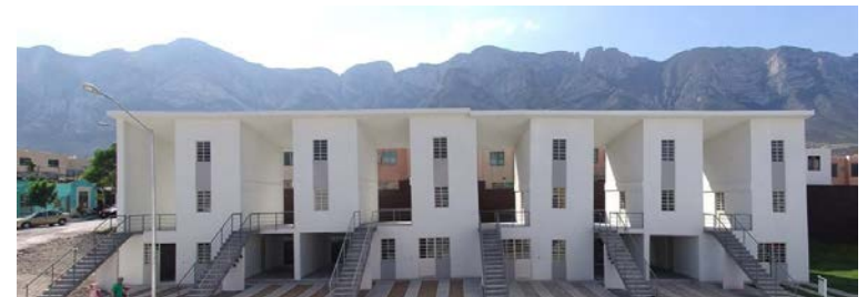
Ilustración 33: Fachada principal de apartamentos
