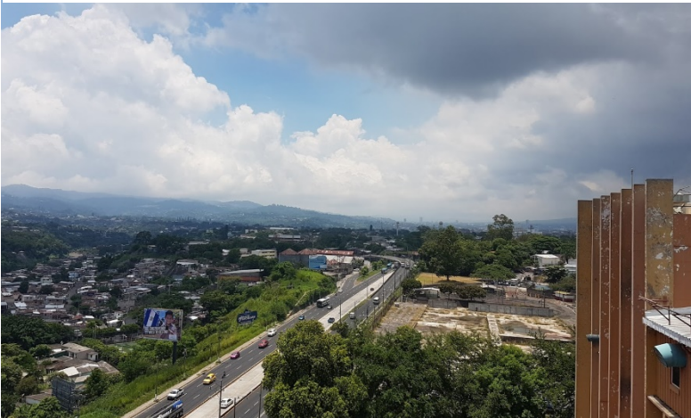
Fotografía 25: Boulevard del Ejercito Vista Aérea.
