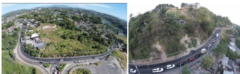
Fotografía 20: Calle Agua Caliente y 50a Avenida Norte
