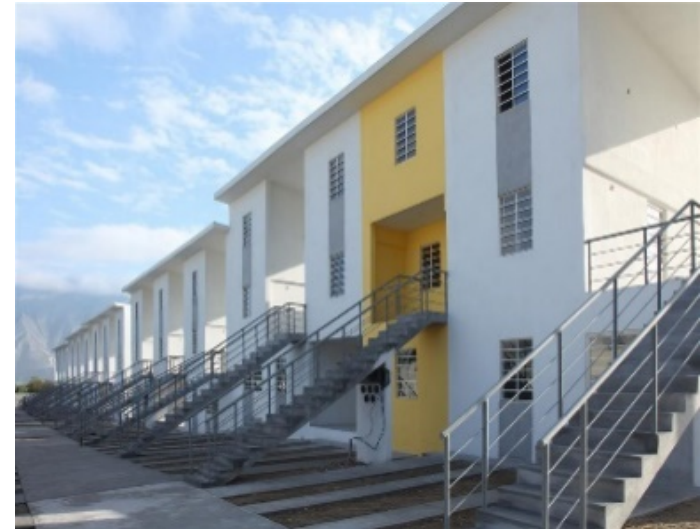
Ilustración 35: Construcción final del proyecto
