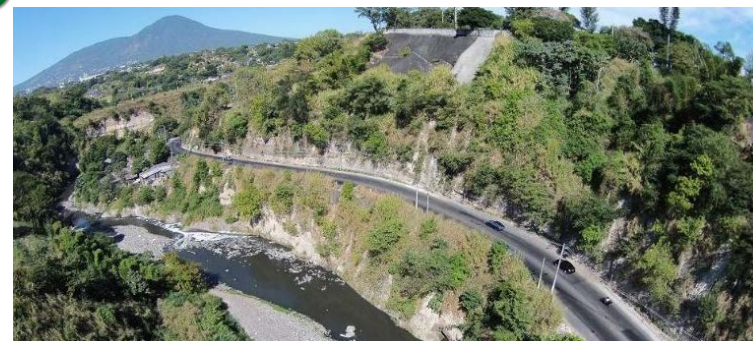
Fotografía 22: Canal principal del Rio Acelhuate
