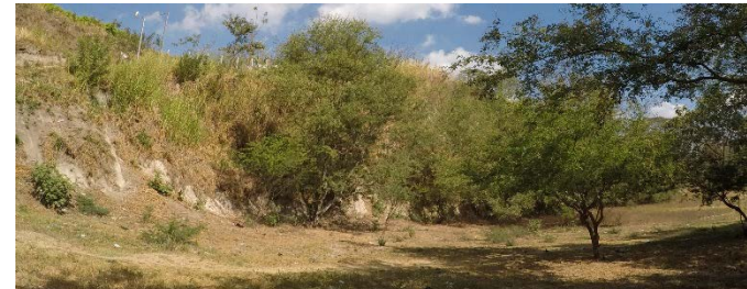
Fotografía 12: Talud ubicado al costado poniente del terreno
