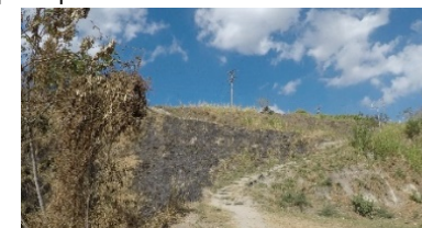
Fotografía 2: Acceso punto B
