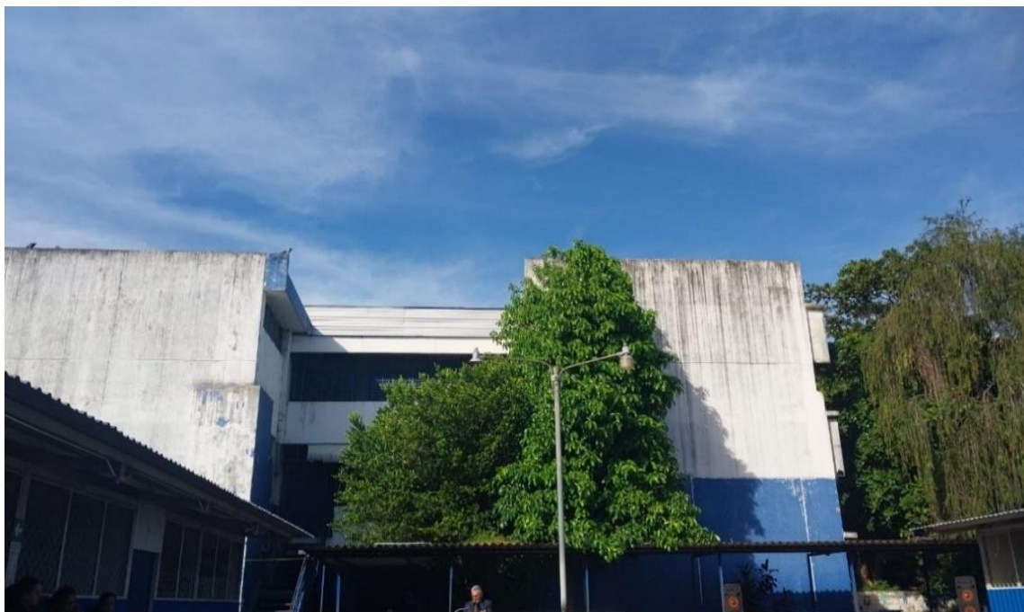
Edificio principal del Centro Escolar Colonia San Ramón
