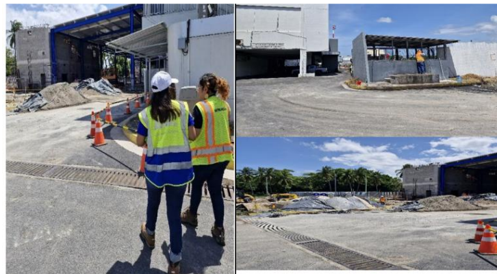
Figura 8. Aérea de construcción dentro del aeropuerto en el área de operaciones.
