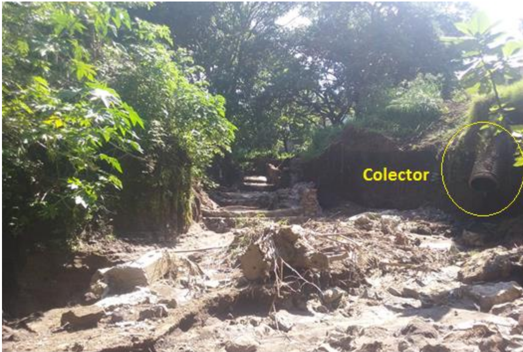
Fotografía 1- 2. Descarga de aguas lluvias de Urbanización Jardines Del Rocío.
