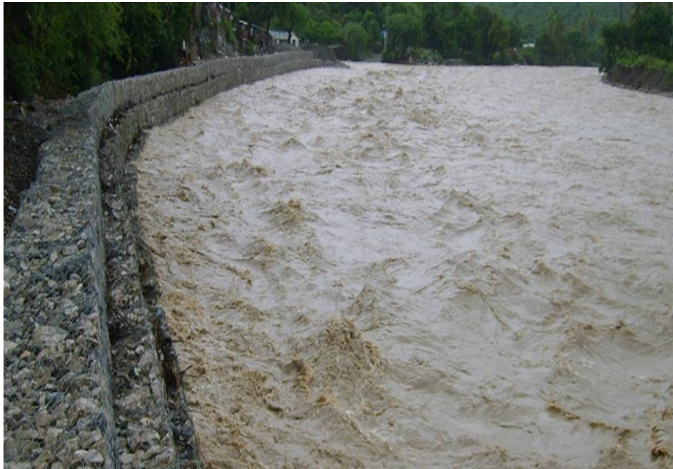
Figura 2- 17. Gavión instalado a orillas del río Tunes.
