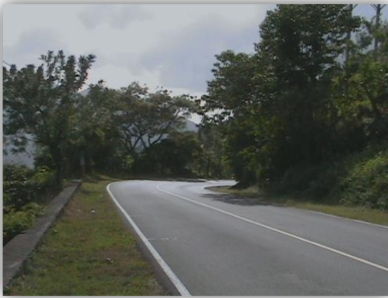
FIG.Nº 40 Carretera que conduce de Alegría hacia Santiago de María
