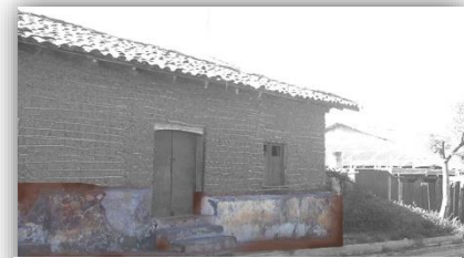
FIG. Nº3 3ª calle poniente, cuadra B-2
