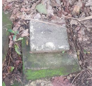
Figura 10. Acometida de agua potable en el parque.
