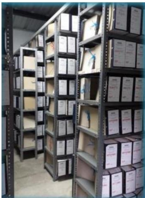
Fotografía 1: estanterías dexion reforzadas con bastoneo por fila y empernado entre sí por cada cuerpo.
