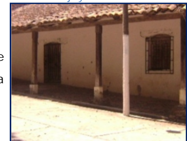
Puerta y ventana de madera
