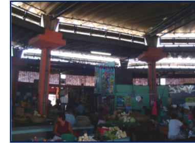
Estructura de techos de mercado
