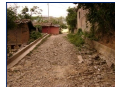
Calle en Barrio San Antonio, sin recubrimiento
