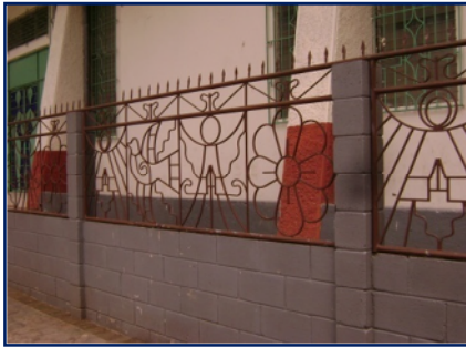
Barandal en Iglesia Central
