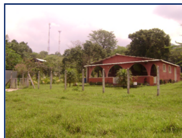
Vista 2. Zona en proceso de urbanización
