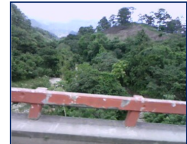
Puente sobre el Río San Ignacio
