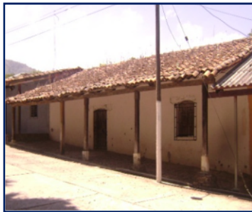
Basa de piedra en columnas
