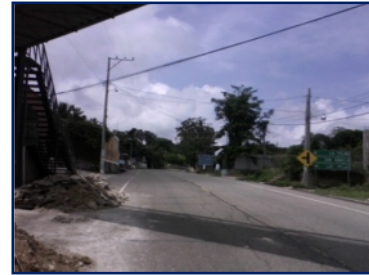
Carretera Troncal del Norte, recubierta de asfalto
