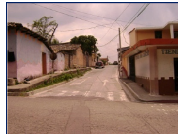
5ta C. Poniente, recubierta de concreto
