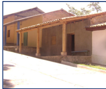
Basa de concreto en columnas
