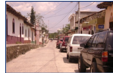
Avenida Baden Pawell, recubierta con concreto
