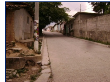
C. al Cementerio, recubierta con concreto
