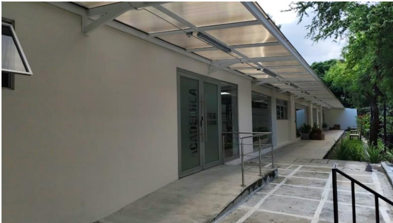
Figura 5 Fachada actual del Edificio de Administración Académica
