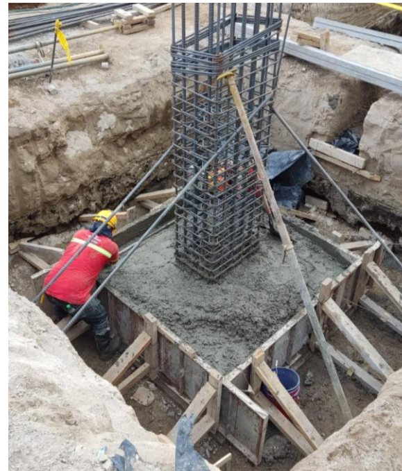
Figura 44 Proceso de colado de zapatas
