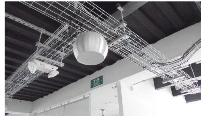
Figura 37 Instalación de bandejas eléctricas en edificio
