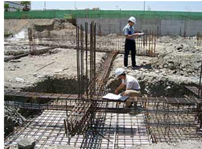
Figura 57 Validación de armado de acero
