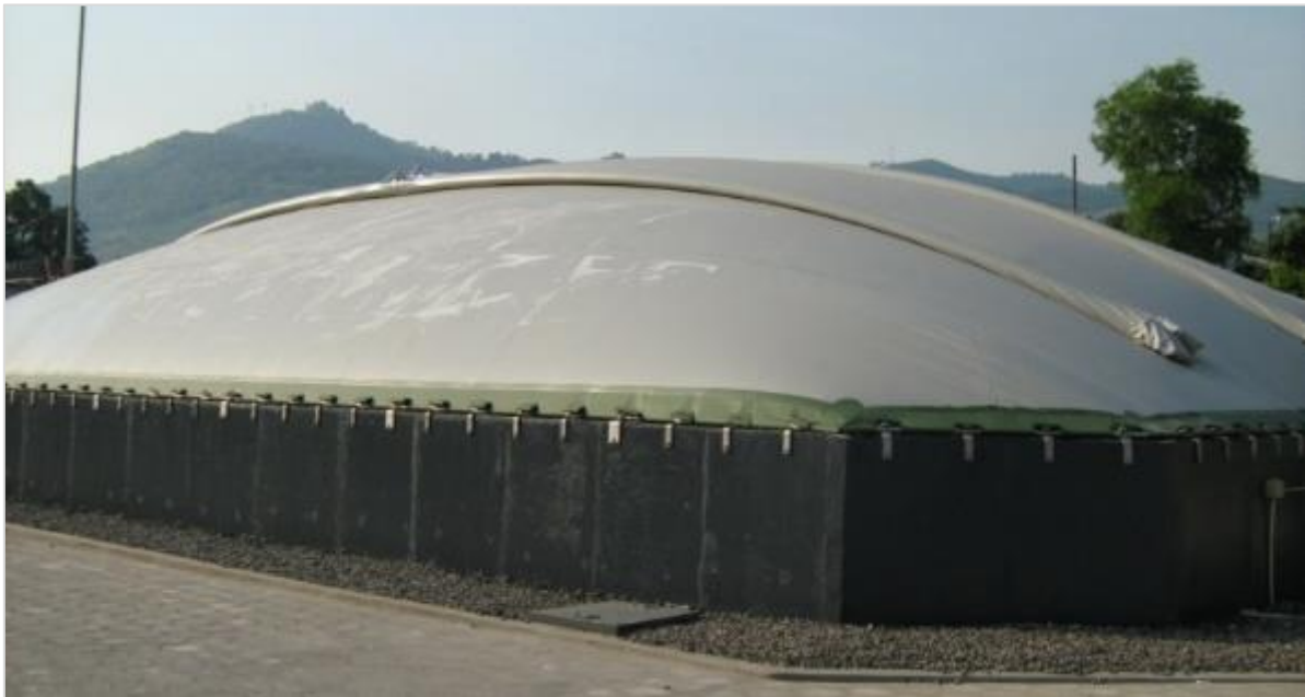
Figura 4 Planta de tratamiento de agua Planta Cerveza, presentación de Gestión Ambiental 2019, (Constancia, 2010).
