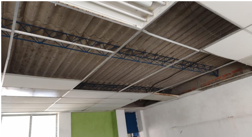
Imagen No. 6-1. Estructura y cubierta de techos
