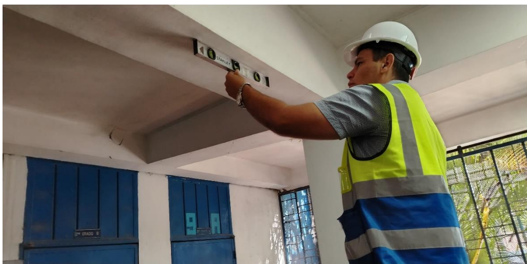
Imagen No. 6-3. Verificación de verticalidad en columna tipo C-1, eje F,4.
