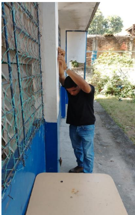
Imagen No. 6-3. Verificación de verticalidad en columna tipo C-1, eje F,4.
