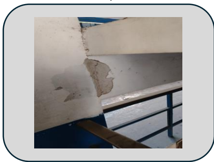
Imagen No. 5-5. Esquema de daños en viga de descanso de escaleras, segundo nivel.
