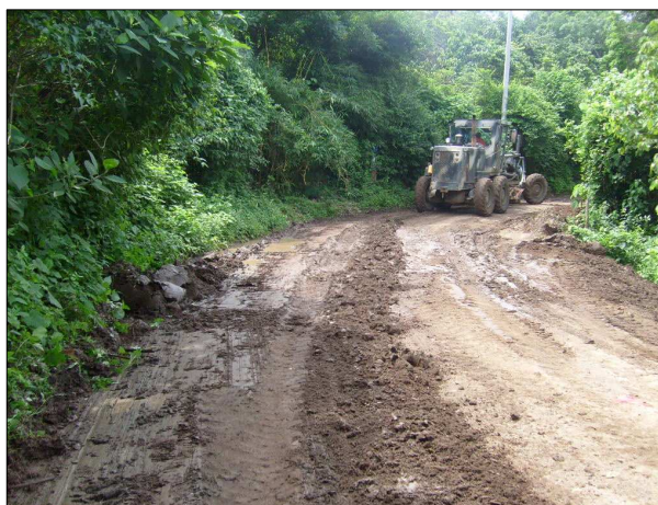
Fotografía 5.1 Preparación del lugar previo a su estabilización.
