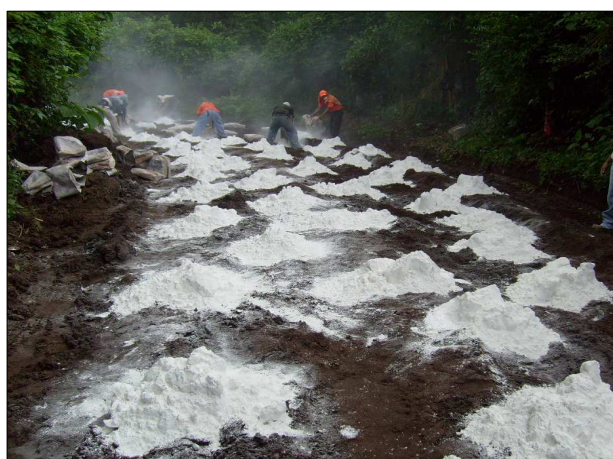
Fotografía 5.5 Colocación de la cal previamente distribuida.
