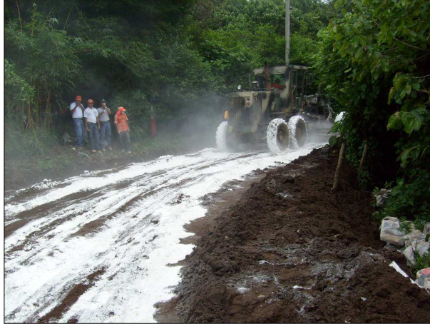
Fotografía 5.6 Extendido de la cal previo a su mezclado.
