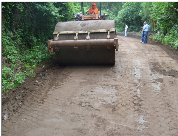
Fotografía 5.9 Proceso de compactación de la mezcla suelo-cal.
