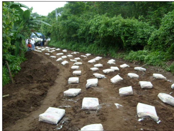
Fotografía 5.3 Distribución de la cal en tramo a estabilizar
