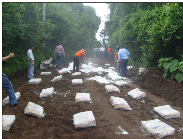
Fotografía 5.4 Rompimiento de la cal sobre el suelo a estabilizar
