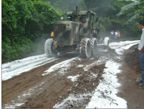
Fotografía 5.8 Proceso de mezclado del suelo-cal.
