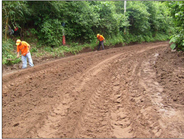
Fotografía 5.2 Aireación del suelo previo a su estabilización.
