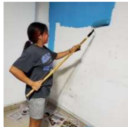
Fig.45.Remodelación. Fuente. Elaboración propia
