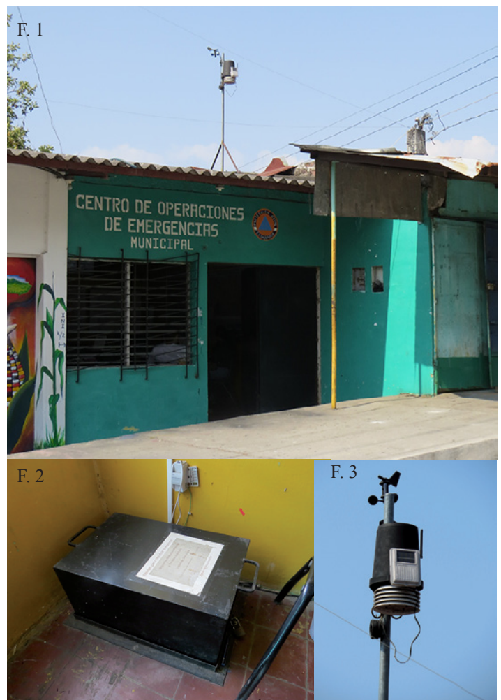
▲ F. 1, Centro de Operaciones de Emergencia Municipal, en Guadalupe San Vicente. F. 2. Equipo para registrar sismos. F. 3. Estación meteorológica.
