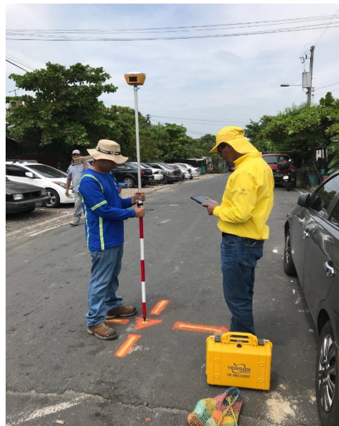
Imagen No. 10 - 16. Medición de PCF-6. Fuente: Elaboración propia.
