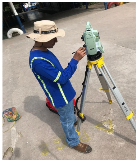
Imagen No. 11 - 6. Centrado y nivelado de estación total en Plg-2.
