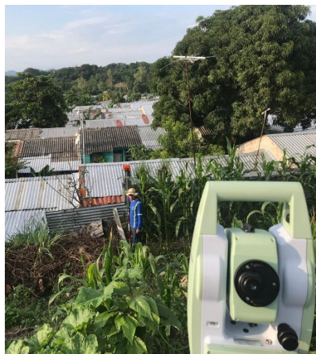
Imagen No. 11 - 5. Medición de punto en zona de tapial.
