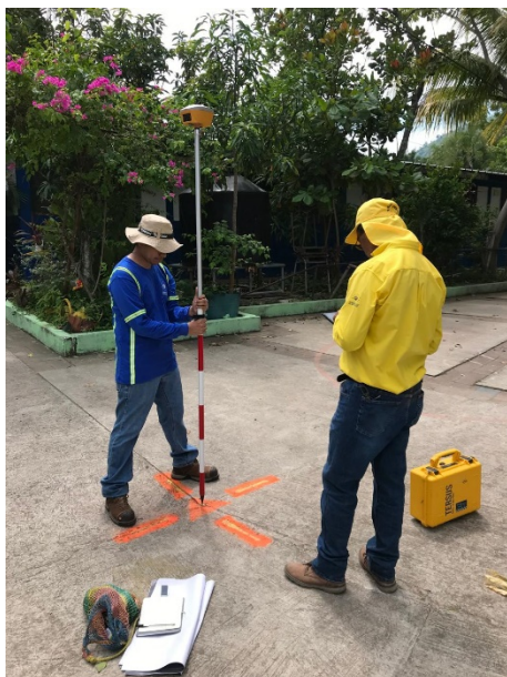
Imagen No. 10 - 15. Medición de PCF-7. Fuente: Elaboración propia.
