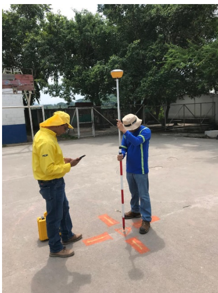
Imagen No. 10 - 17. Medición de PCF-8. Fuente: Elaboración propia.
