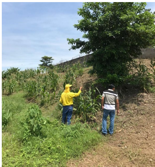
Imagen No. 10 - 5. Recorrido exterior de muro perimetral. Fuente: Elaboración propia.
