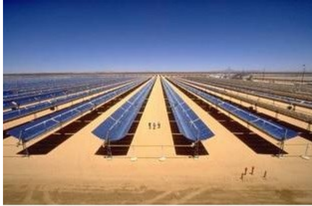
Figura 1.3. Planta termosolar construida con CCP en el desierto de Mojave, California. ( Termosolar, 2014 )
