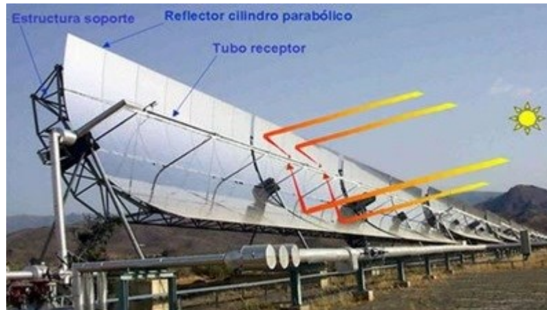
Figura 2.3. Esquema de un concentrador de radiación solar cilíndrico parabólico. (Olivare, Aldana, & Moreno, 2014)
