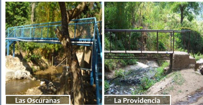
IMAGEN No. 1 Puentes peatonales en el Río San Antonio ubicado en el límite del Caserío Las Oscuranas y en el Río Asuchío ubicado en la línea fronteriza del Caserío La Mascota y La Providencia.
