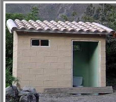
IMAGEN No. 2 Caseta de letrina.
