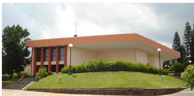
IMAGEN No. 57 Iglesia de denominación católica, en la Casa de Retiro “Sagrado Corazón” de la congregación salesiana en El Salvador.
