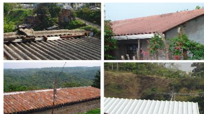
IMAGEN No. 32 Materiales de cubiertas de techos en viviendas, lámina de asbesto cemento, lámina de fibrocemento, teja y lámina metálica.
