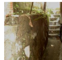
FOTOGRAFÍA No. 3 Obras improvisadas de retención de talud.
