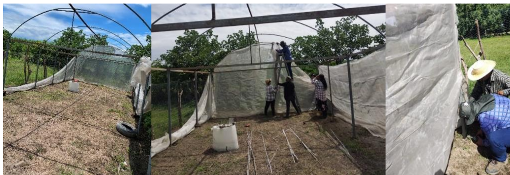
Figura 35. Instalación de malla anti insectos en huerto comunitario de Las Américas 3 y 4 de Nejapa.
