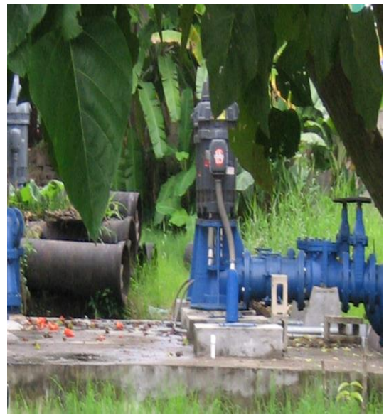
Figura N° 10 Cisterna de la planta de ANDA
