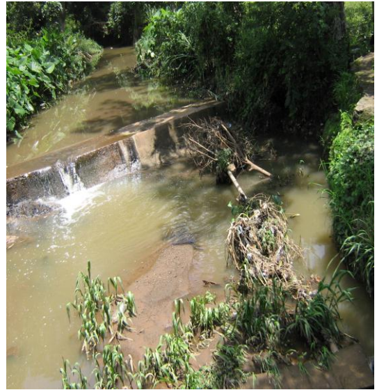
Figura N° 6 Río a 70 mts antes de planta de ANDA.
