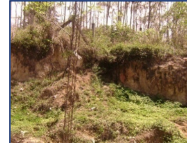
Protección en Parque La Cruz deteriorada
