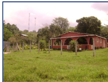
Vista 2. Zona en proceso de urbanización
