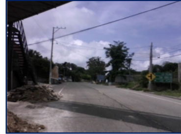
Carretera Troncal del Norte, recubierta de asfalto
