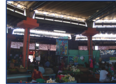
Estructura de techos de mercado
