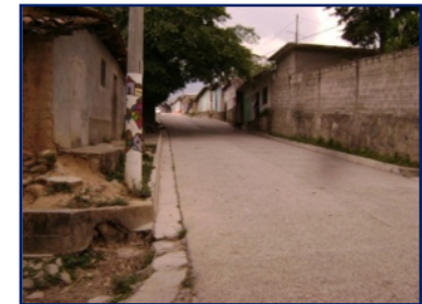
C. al Cementerio, recubierta con concreto
