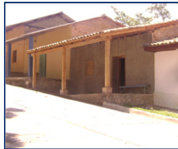
Basa de concreto en columnas
