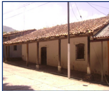
Basa de piedra en columnas
