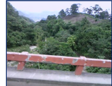
Puente sobre el Río San Ignacio
