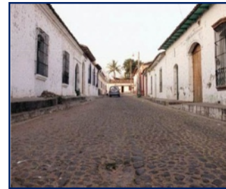
Calle empedrada de Suchitoto
