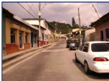
Av. Matías Delgado, recubierta con asfalto
