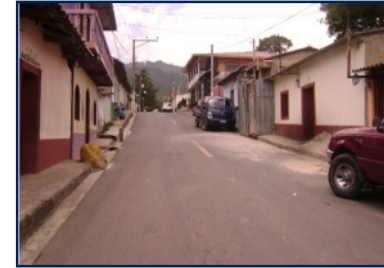
Calle Cayaguanca, hacia las pilas. Recubierta de asfalto
