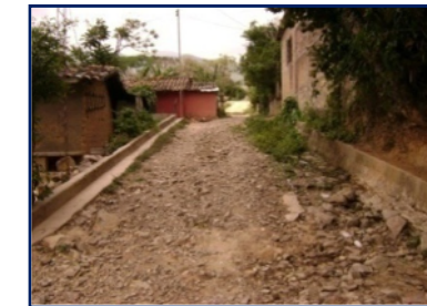
Calle en Barrio San Antonio, sin recubrimiento
