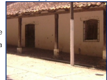
Puerta y ventana de madera
