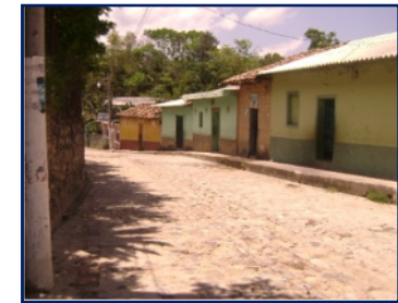
Techos de teja y fibrocemento
