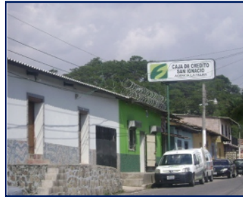
Techos de fibrocemento
