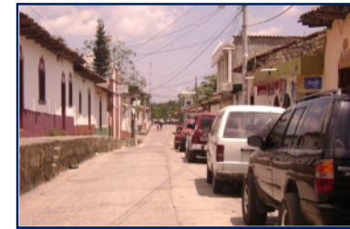
Avenida Baden Pawell, recubierta con concreto
