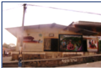
Poste de tendido telefónico
