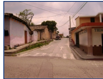
5ta C. Poniente, recubierta de concreto
