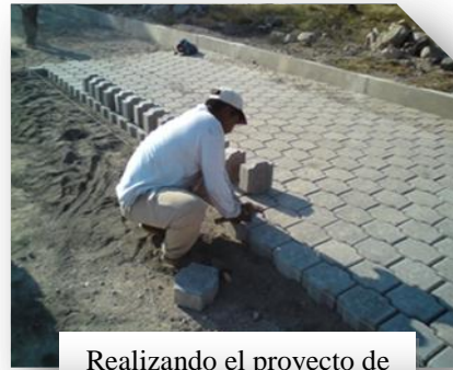
Realizando el proyecto de Estacionamiento.
