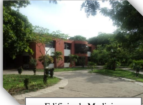
Edificio de Medicina Módulo de aulas.
