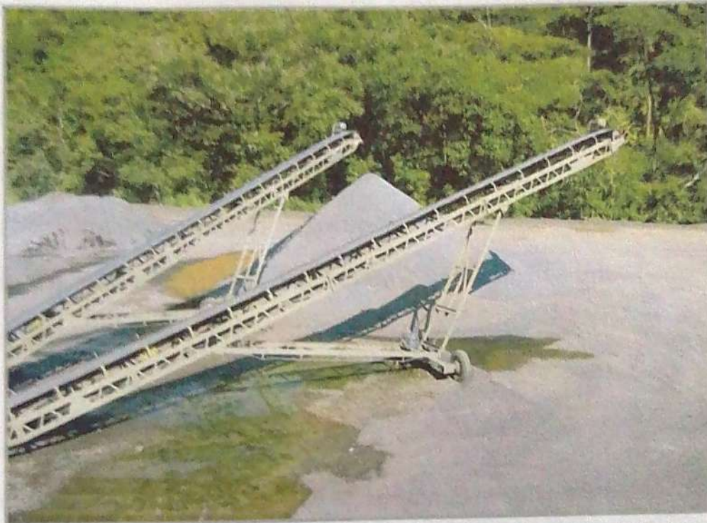
Figura 2.21. Bandas transportadoras para almacenamiento de materiales. Pedrera La Cantera (San Diego), Municipio Puerto La Libertad, La Libertad.
