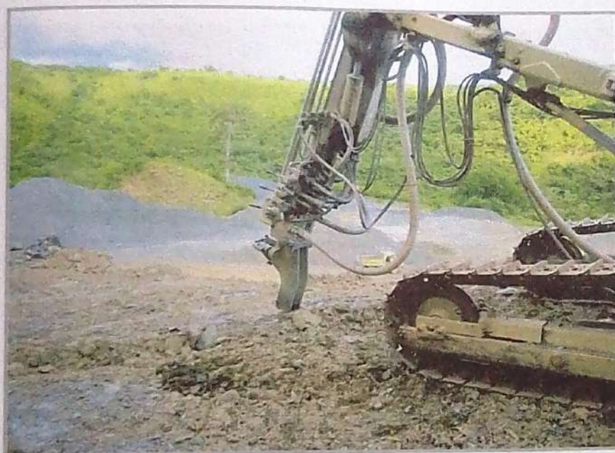
Figura 2.35. Proceso de perforación de la roca para su extracción por medio de voladura.
