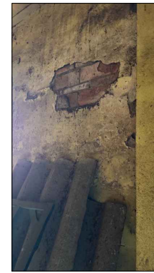
15-ESTADO ACTUAL DE MURO IMG_1524.HEIC
