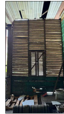
19-DETALLE CELOSÍA Y CIELO FALSO IMG_1531.HEIC
