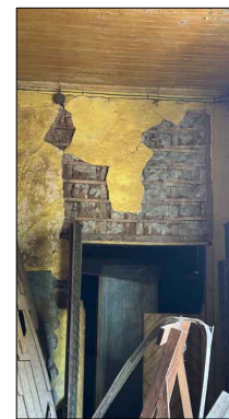
16-ESTADO ACTUAL DE MURO IMG_1525.HEIC
