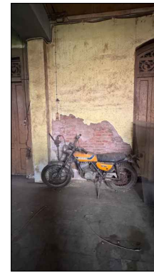
14-ESTADO ACTUAL DE MURO Y PISO IMG_1518.HEIC
