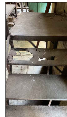
17-ESTADO ACTUAL DE ESCALERA 2 TIPO L IMG_1527.HEIC
