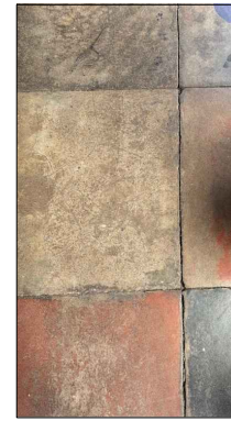
1-DETALLE DE PISO EN VESTIBULO IMG_1470.HEIC
