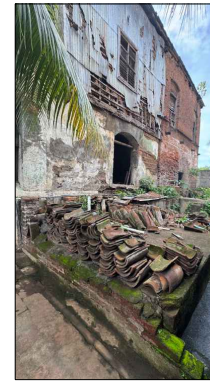
6-ESTADO ACTUAL DE FACHADA OESTE IMG_1494.HEIC
