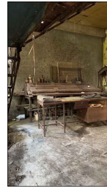
8-PUERTAS ORIGINALES SUSTITUIDAS IMG_1504.HEIC
