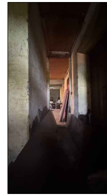
11-ESTADO ACTUAL DE PASILLO IMG_1511.HEIC
