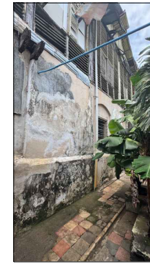
3-ESTADO ACTUAL FACHADA OESTE IMG_1476.HEIC
