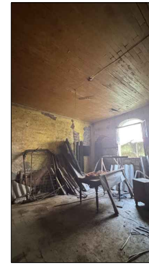
10-ESTADO ACTUAL DE CIELO, PISO Y MURO N1 IMG_1509.HEIC
