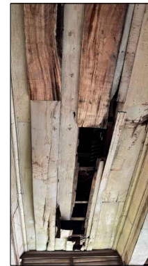
23-ESTADO ACTUAL DE CIELO FALSO N2 IMG_1541.HEIC
