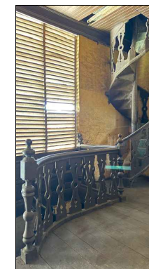
32-ESTADO ACTUAL DE ESCALERA HELICOIDAL IMG_1604.HEIC
