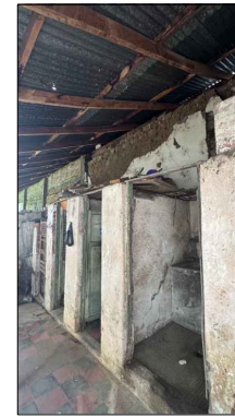
5-ESTADO ACTUAL DE BAÑOS Y DUCHAS IMG_1492.HEIC
