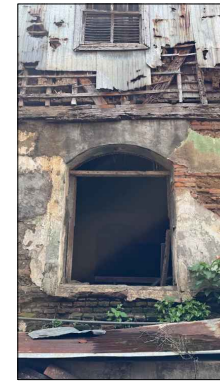
7-DETALLE DE VENTANA EN NIVEL 1 IMG_1496.HEIC
