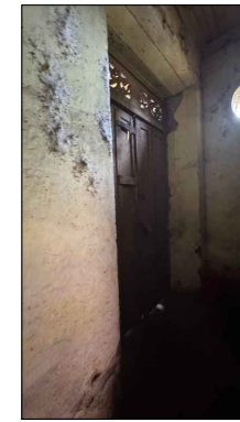
13-ESTADO ACTUAL DE MURO Y PUERTA IMG_1517.HEIC
