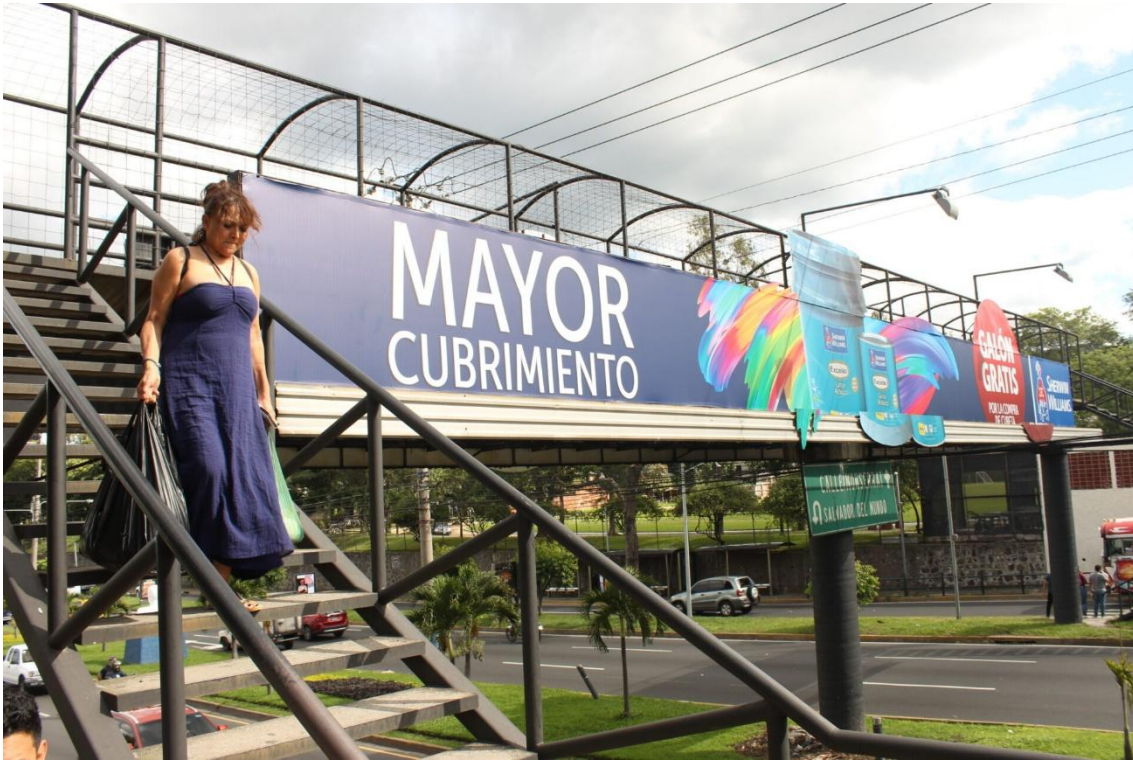
Pasarela convertida en valla publicitaria en el Bulevar de Los Próceres, San Salvador. FOTO: Ariel De León.
