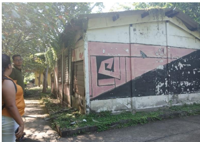
Imagen 5 Espacio designado para apilar residuos de aparatos eléctricos y electrónicos, ubicado en zona de Biología, a fecha agosto 2024.
