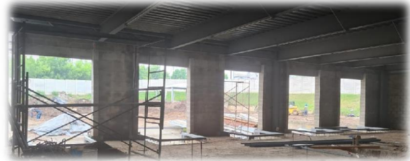
Fotografía 5: PROCESO DE CONSTRUCCION Fuente: Google GBox Cargo Almacenes Logísticos
