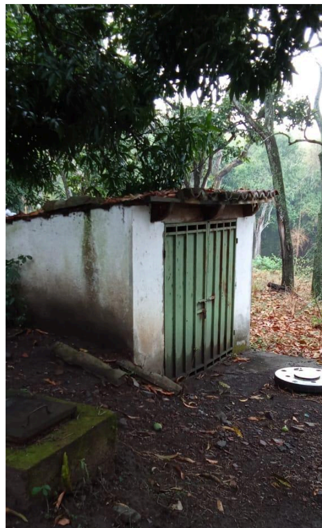
Figura 71: Necesidad de demolición de Infraestructura existente
