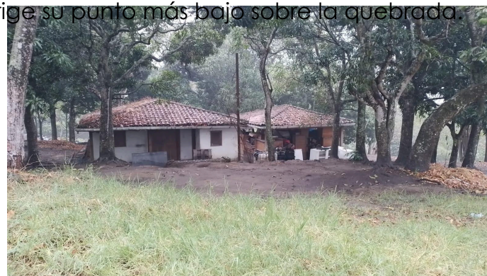
Figura 42. Fotografía infraestructura existente vivienda habitada
