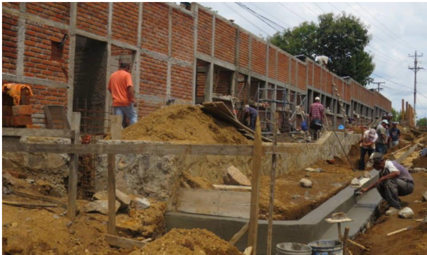
Imagen n°50. Utilización de materiales tradicionales.
