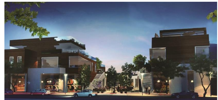
Imagen nº47: vista terminada del proyecto
