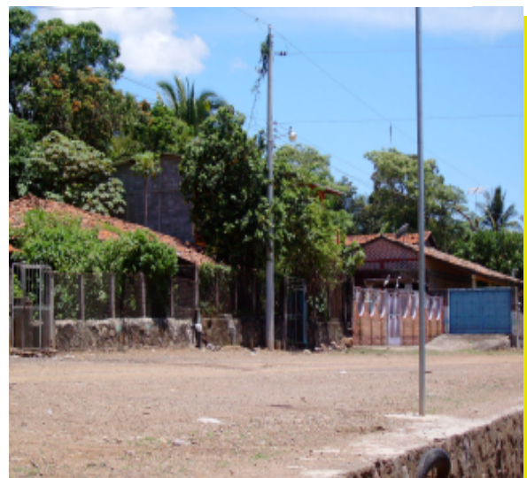
Fig. 44 Postes de la Red Eléctrica
