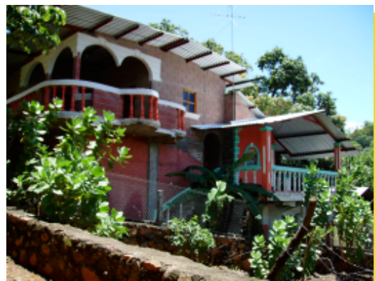
Fig. 51 Vivienda con Arquitectura Vernacular
