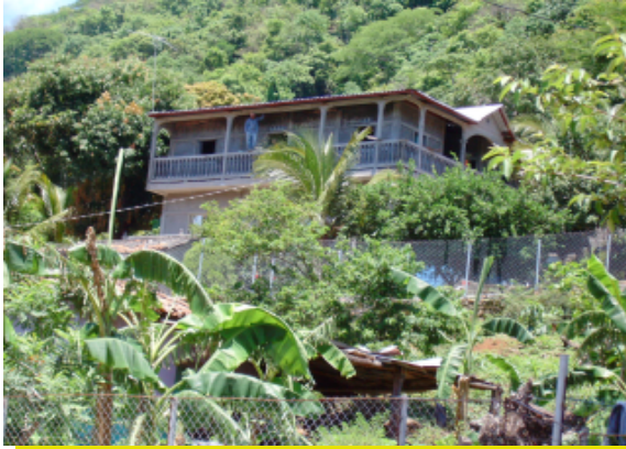
Fig. 52 Vivienda con Arquitectura Vernacular
