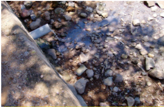
Fig. 42 y 43 Drenaje de aguas pluviales Provenientes de Las pilas de las viviendas
