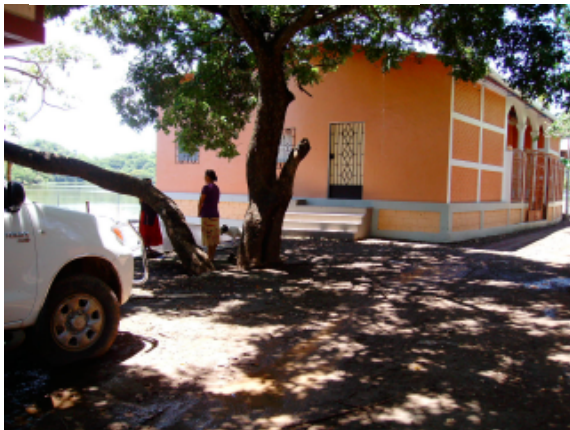
Fig. 50 Vivienda con Arquitectura Vernacular
