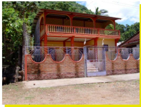
Fig. 53 Vivienda con Arquitectura Vernacular
