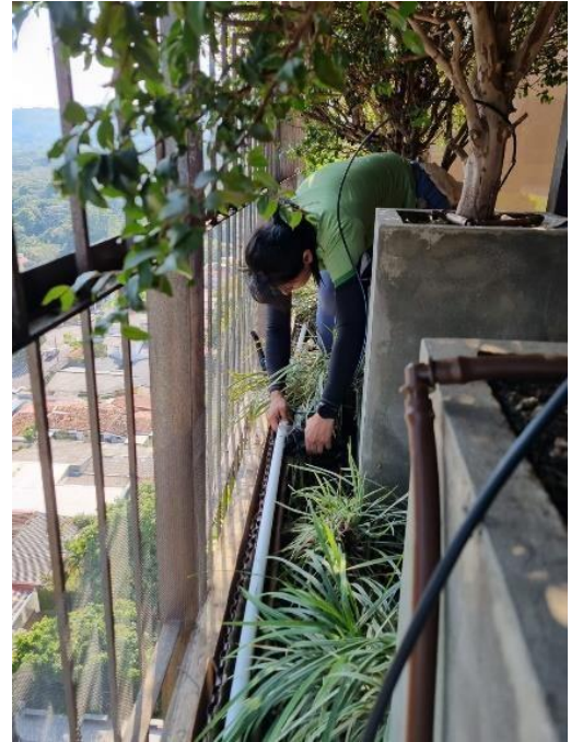
Colocación de tubería P.V.C 3/4
