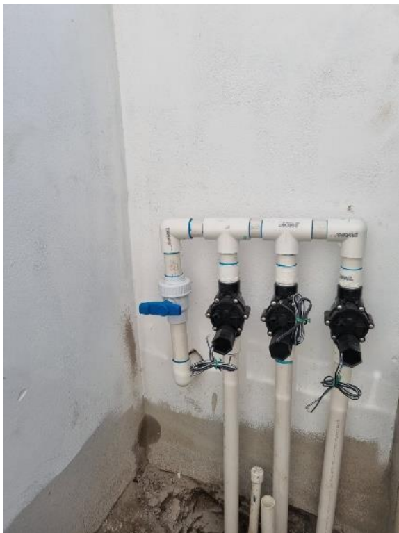
Instalación de válvulas.
