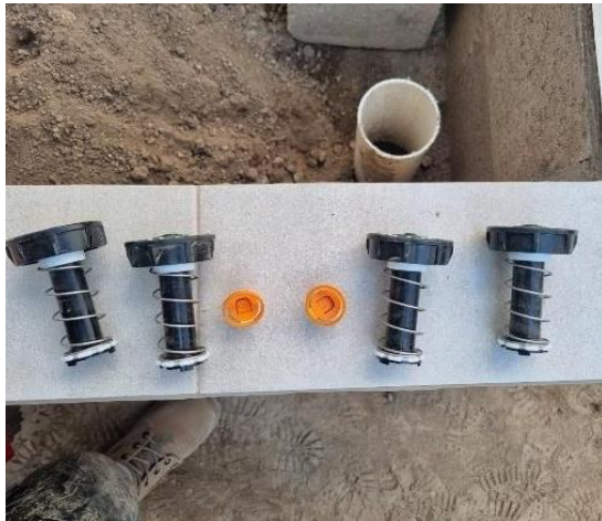
Limpiando impurezas en las tuberías.
