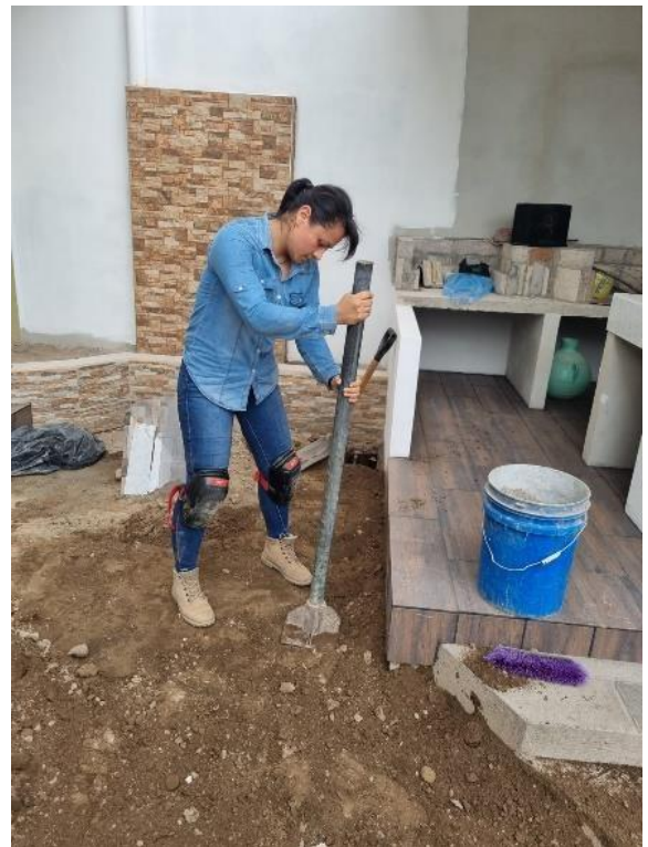
Compactar el suelo.
