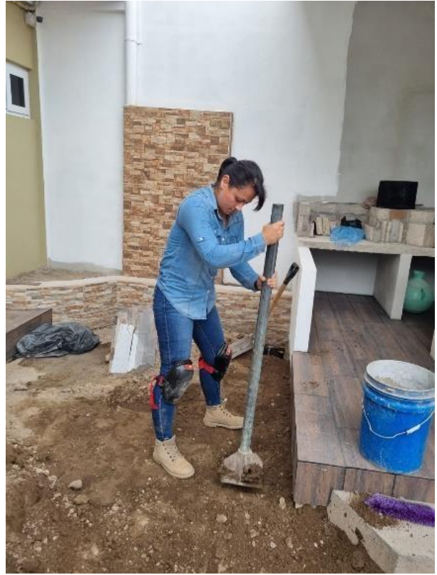
Compactado de suelo y aterrado de tuberías.
