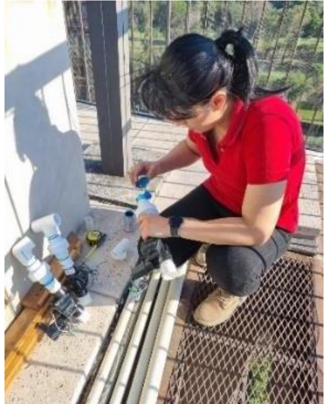
Colocación de tubos y tee a electroválvulas.
