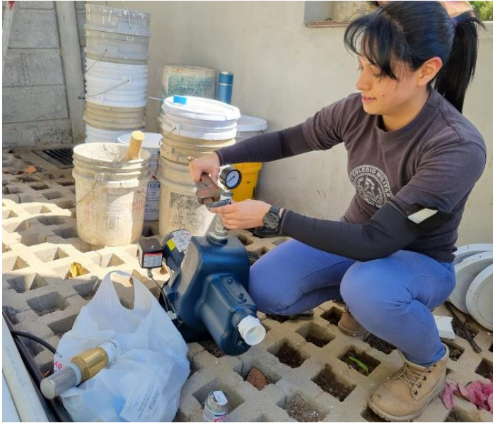
Colocación de accesorios en succión y descarga de la bomba.
