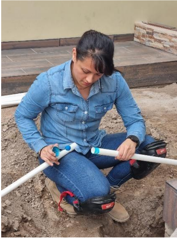
Instalación de tuberías \frac{3}{4} 250 PSI.
