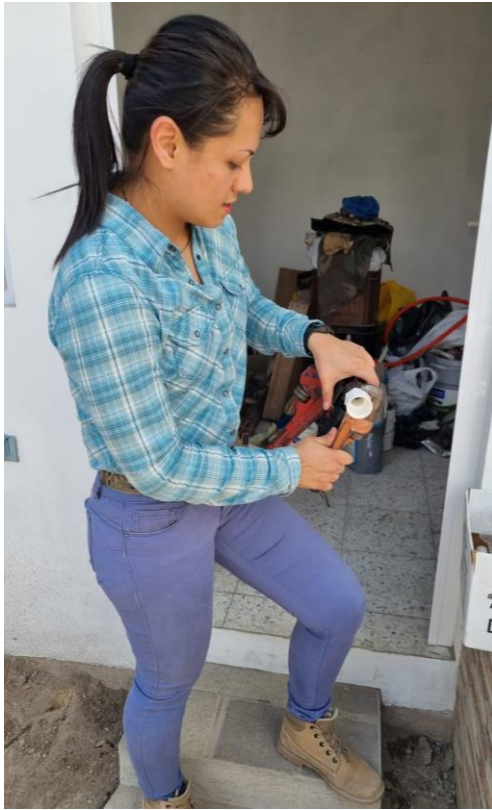
Armado de válvulas.
