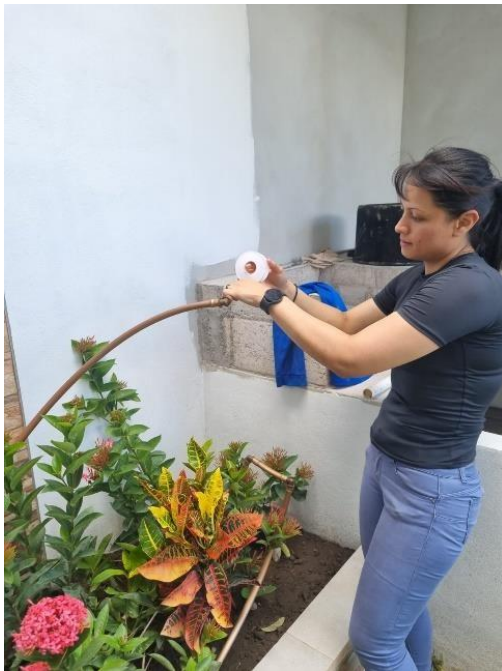
Instalación de manguera por goteo y accesorios.
