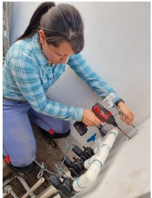
Instalación de sensor de lluvia.
