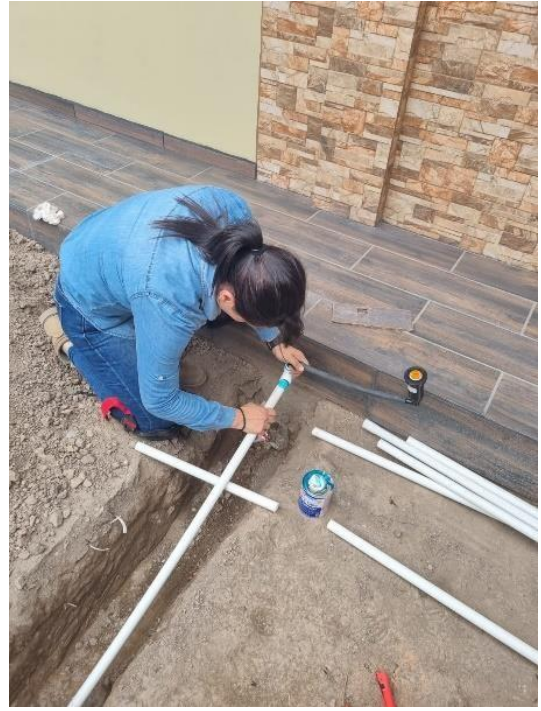
Colocación de surtidores.
