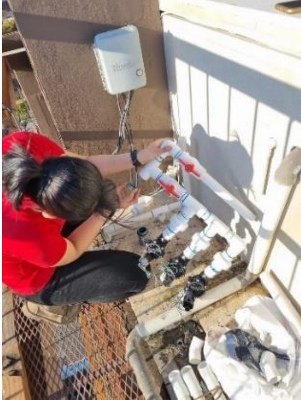
Armado de tuberías y electroválvulas a la pared.
