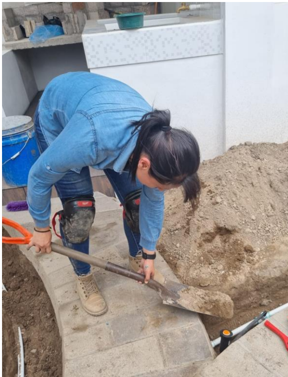
Aterrado de tuberías.
