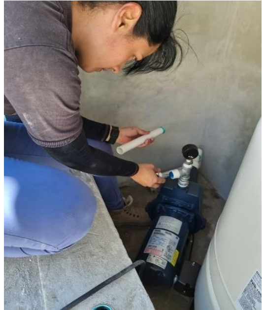
Instalación de la cisterna.
