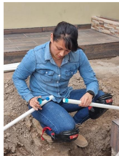
Colocación de tuberías.
