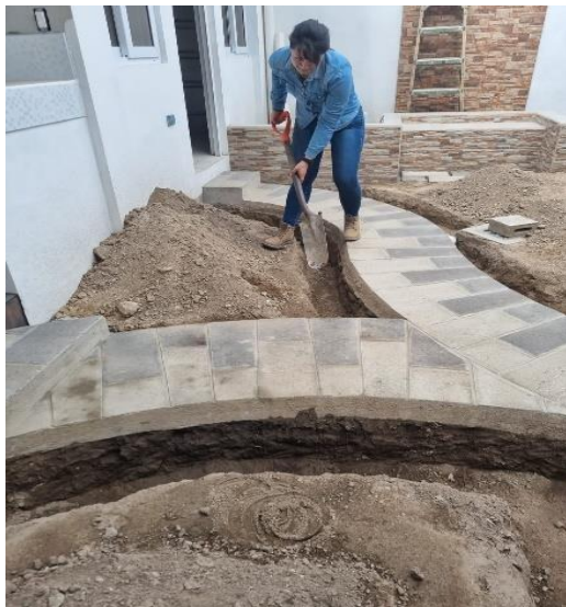
Zanjeo del área.
