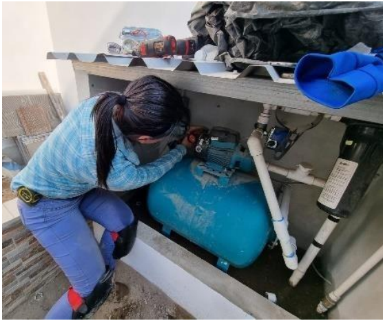
Instalación de programador.
