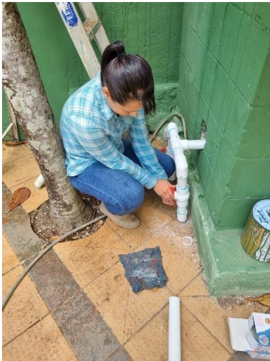
Se abre paso de agua y se ceba bomba.
