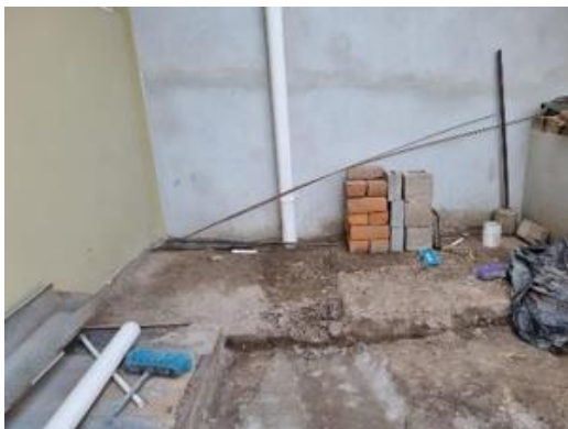
Lugar de construcción de las jardineras.
