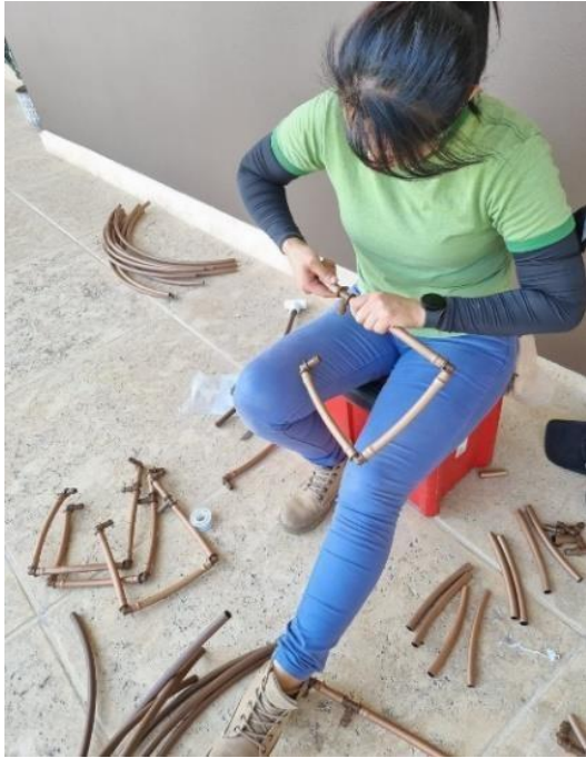
Armado de manguera por goteo.
