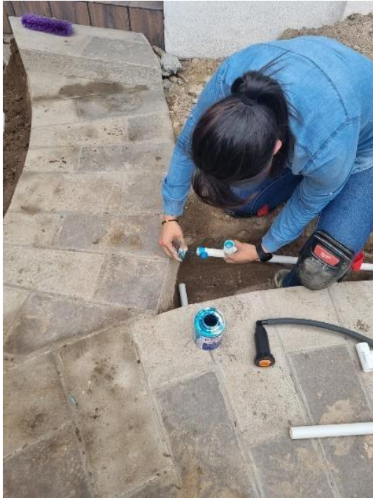
Colocación de codos y Tee PVC.
