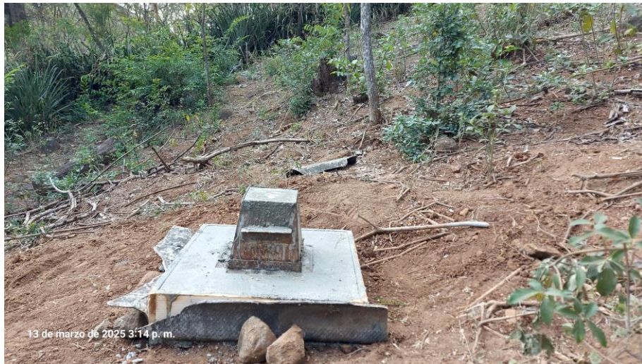
Fotografía 19. Colado de tercera capa de mortero dentro del molde metálico, vértice geodésico PP1M.
