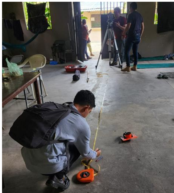
Fotografía 54. Distancia de 5.0 m desde punto identificado para nivelación de estación total.
