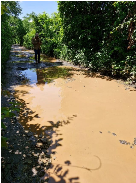
Fotografía 3. Condiciones tras lluvias en el Sector 1 de la calle de acceso a la Comunidad Fe y Esperanza
