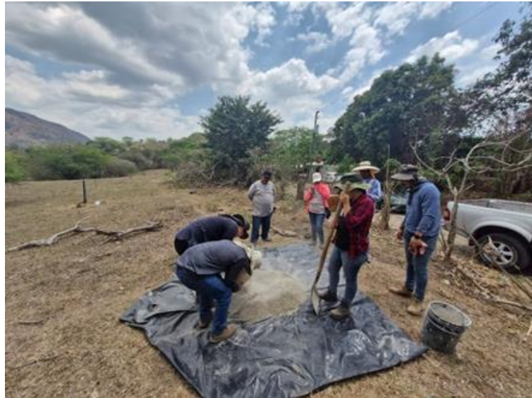
Fotografía No. 30 Elaboración de la mezcla de concreto para la monumentación de los vértices geodésicos
