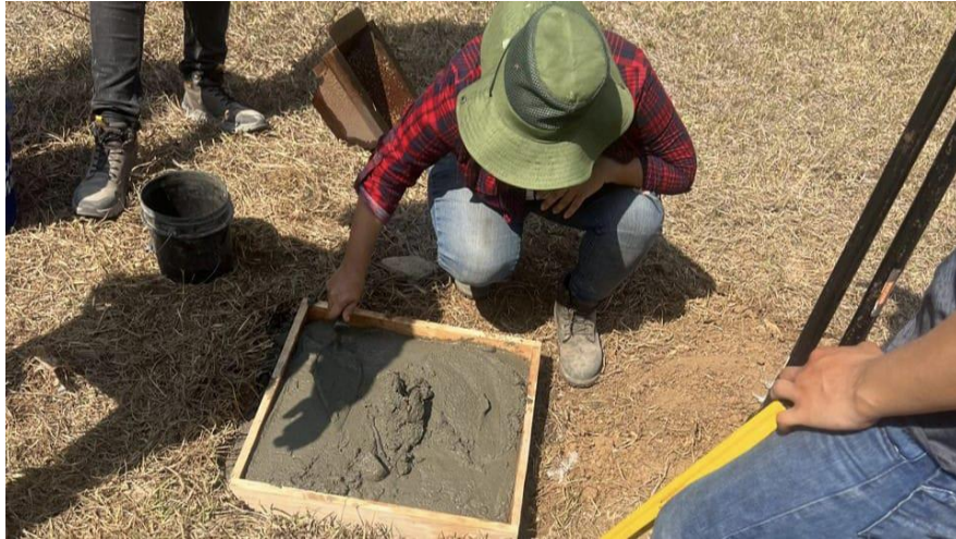
Fotografía 17. Colado de segunda capa de mortero, para el vértice geodésico PP3V.
