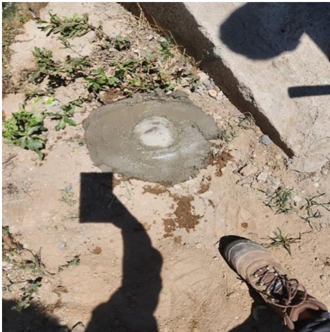
Fotografía No. 42 Monumentación de Punto de Poligonal en calles internas de la comunidad
