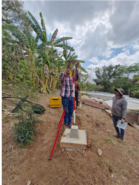
Fotografía No. 35 Instalación del equipo para la medición estática con equipo GNSS
