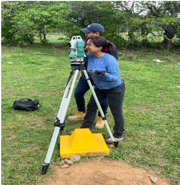
Fotografía No. 49 Ejecución de actividades de topografía en el sitio del proyecto
