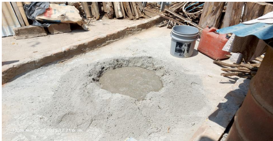
Fotografía 9. Hechura de mortero para colado de vértice geodésico PP1V y PP2M.
