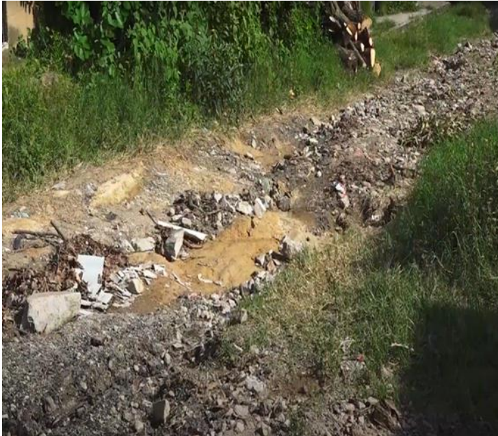
Fotografía 17. Vía de tierra en mal estado, con presencia de baches, acumulación de escombros y material erosionado.
