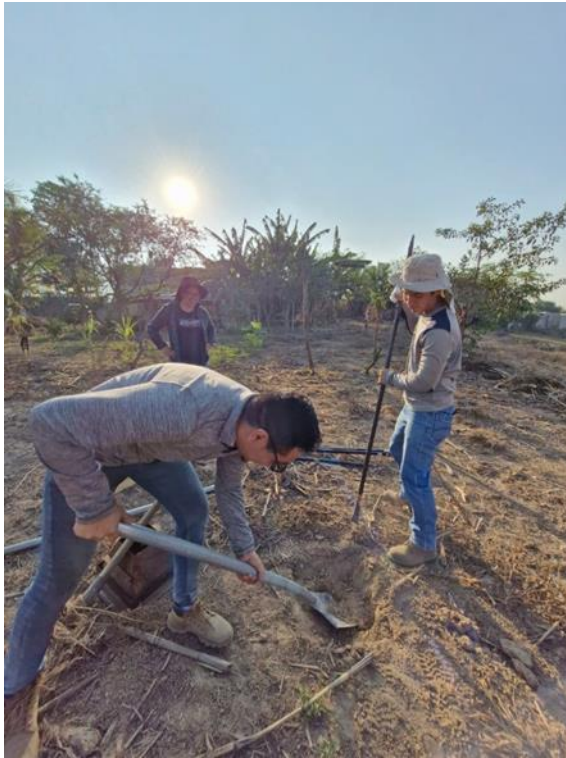
Fotografía No. 28 Excavación para la monumentación de los mojons
