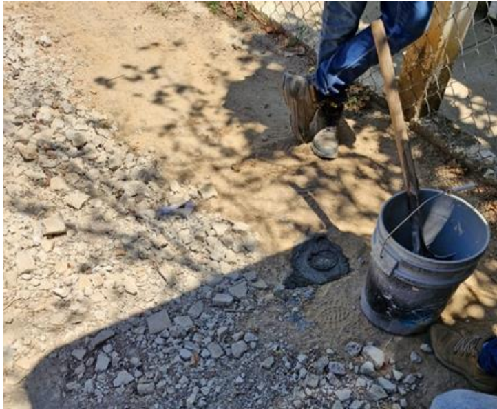
Fotografía No. 39 PLG1 para el Sector 1. Primer tramo del acceso a la Comunidad Fe y Esperanza
