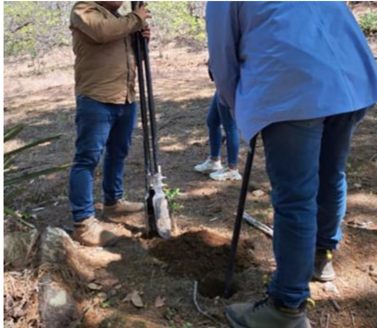
Fotografía 34. Excavación de agujero hasta la profundidad indicada.
