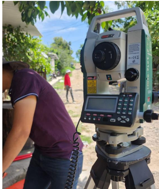
Fotografía 76. Toma de puntos sobre el eje central de la vía.
