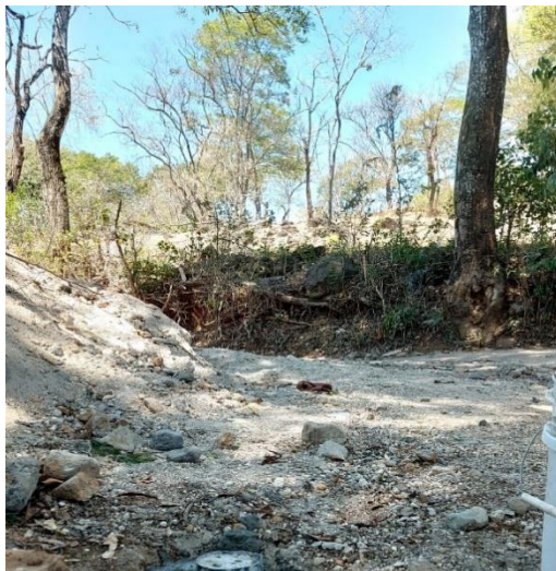
Fotografía 8. Inicio de Sector 2 tramo 1, curva con acumulación de material es su costado, que limita la circulación.
