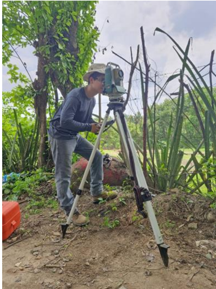
Fotografía No. 47 Levantamiento de los PLG's.
