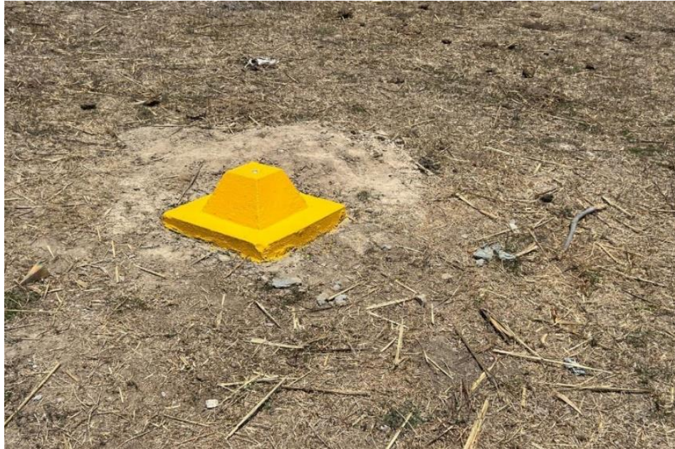
Fotografía 22. Pintura de vértices geodésicos a lo largo de la Comunidad Fe y Esperanza.
