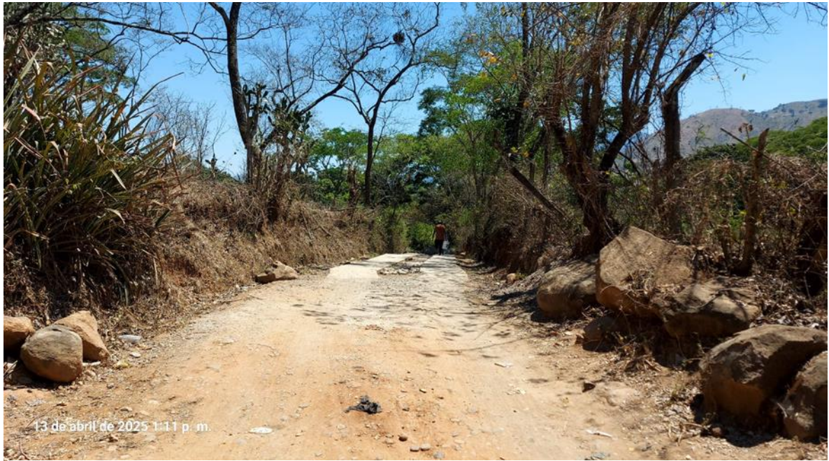
Fotografía 11. Tramo 3. El camino presenta ancho reducido y bordes irregulares , que limita la circulación vehicular
