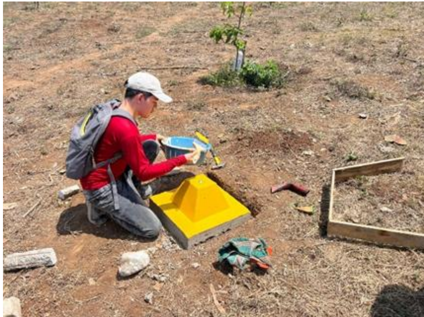
Fotografía No. 33 Retiro de los moldes y pintado de los vértices geodésicos
