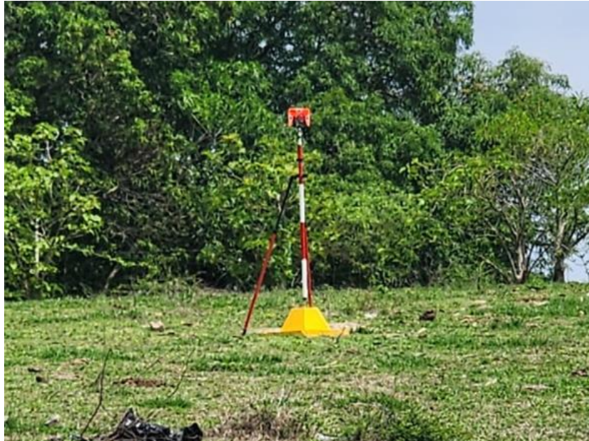
Fotografía 58. Nivelación de prisma para vista atrás en PP3M.
