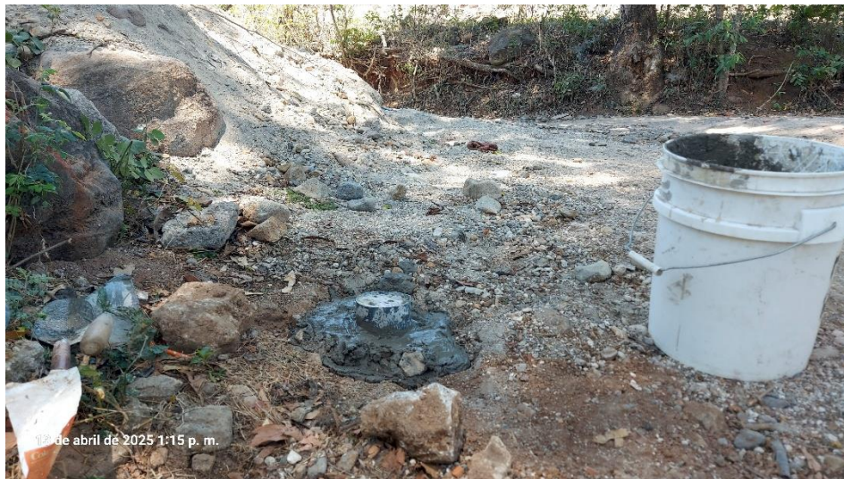
Fotografía 43. Monumentación de PLG1 del sector 2.
