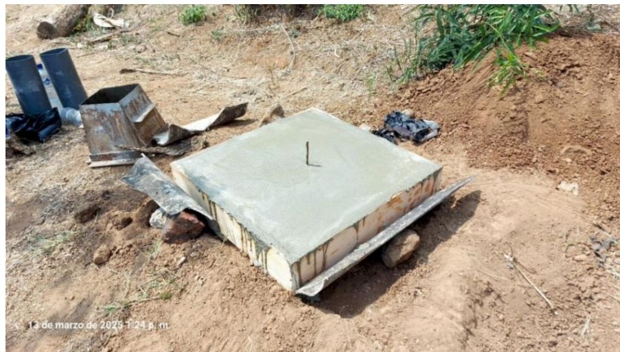
Fotografía 16. Colado de segunda capa de mortero, para el vértice geodésico PP1V.
