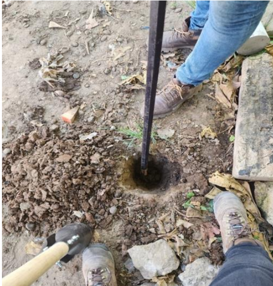
Fotografía No. 37 Realización de excavación manual con barra y pala para la Instalación de referencia en terreno.
