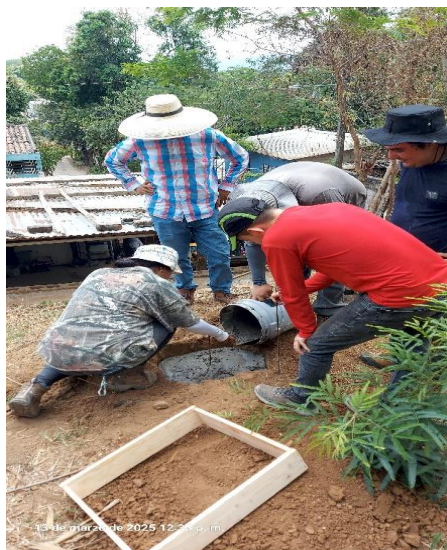
Fotografía 12. Colado de vértice geodésico PP1V.
