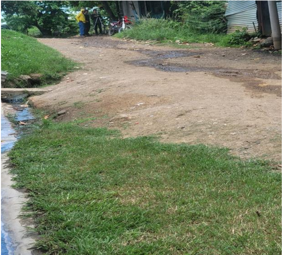
Fotografía No. 18 El drenaje superficial es deficiente, lo que ha provocado estancamiento de agua y deterioro del terreno.
