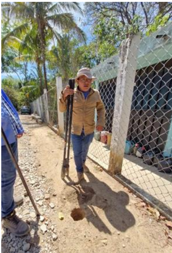
Fotografía No. 38 Excavación para los cilindros usados como mojones para la poligonal abierta (PLG)
