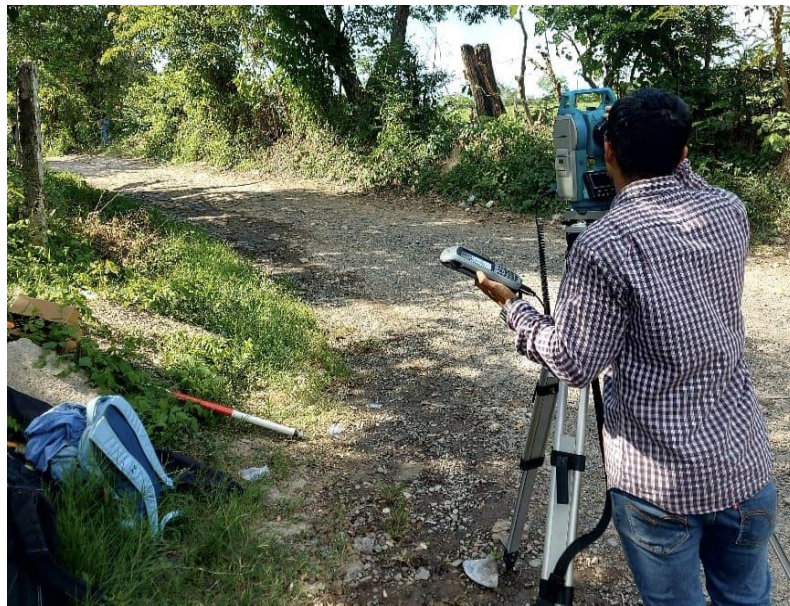
Fotografía 74. Estacionamiento en "mojon de paso", para levantar tramo final del sector 2.
