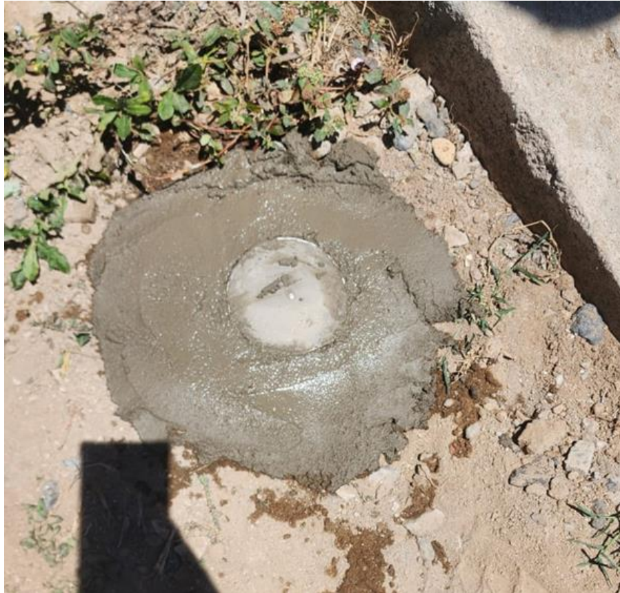
Fotografía 52. Colocación de elemento de PVC en punto PLG identificado en calle de la Comunidad Fe y Esperanza.
