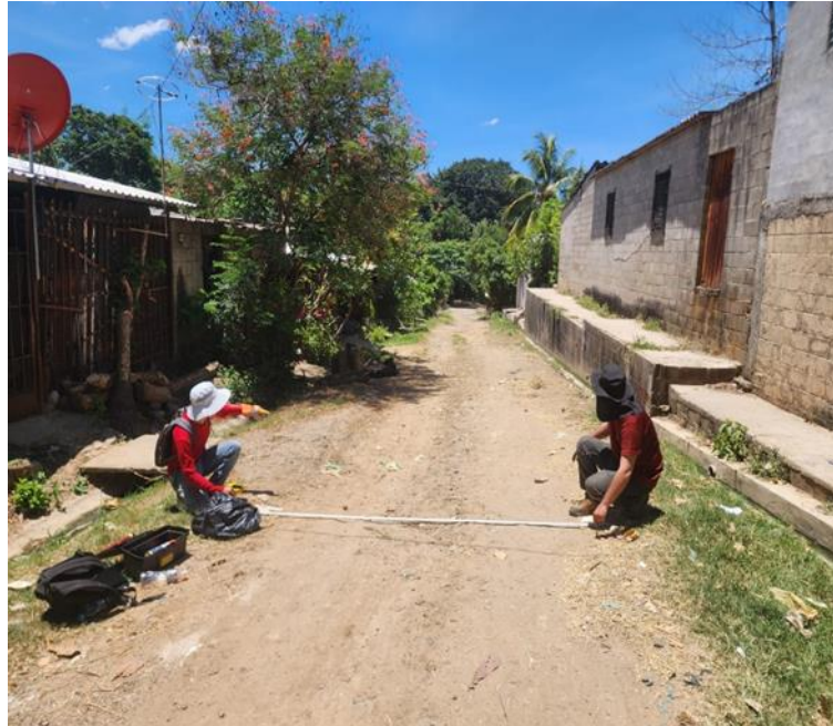
Fotografía No. 14 Vista de huella actual de calle, con terreno irregular y limitado por viviendas a ambos lados.
