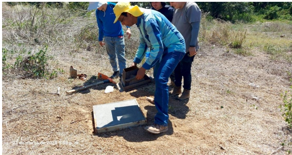
Fotografía 18. Colocación de molde metálico piramidal truncado, para el vértice geodésico PP2M.
