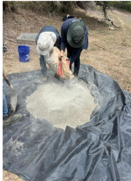
Fotografía 11. Hechura de mortero colar vértice PP3V y PP3M.
