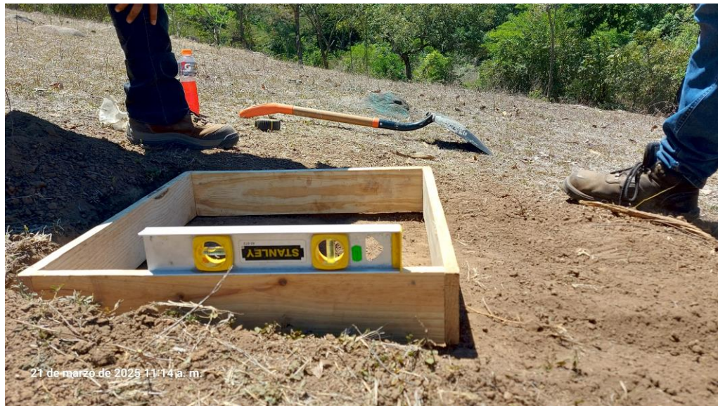
Fotografía 14. Nivelación de contra molde del vértice geodésico PPV2
