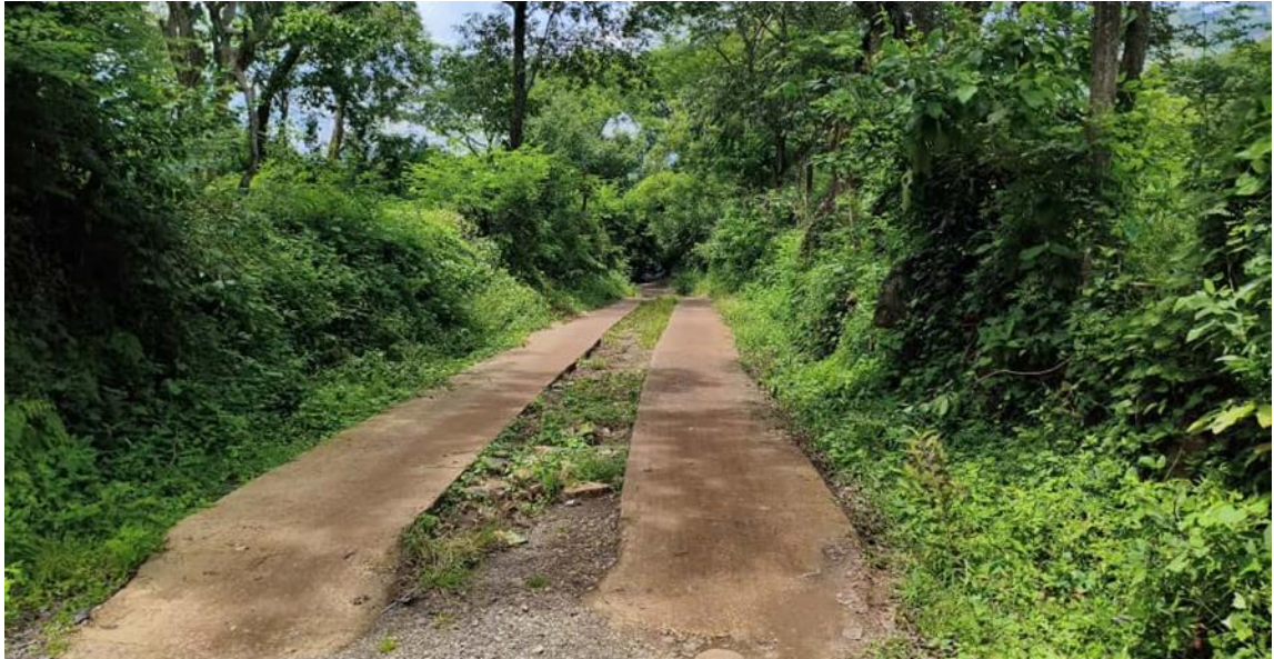
Fotografía 9. Sector 2. Tramo 2. Encintado visto desde la parte superior de la pendiente. En época de invierno
