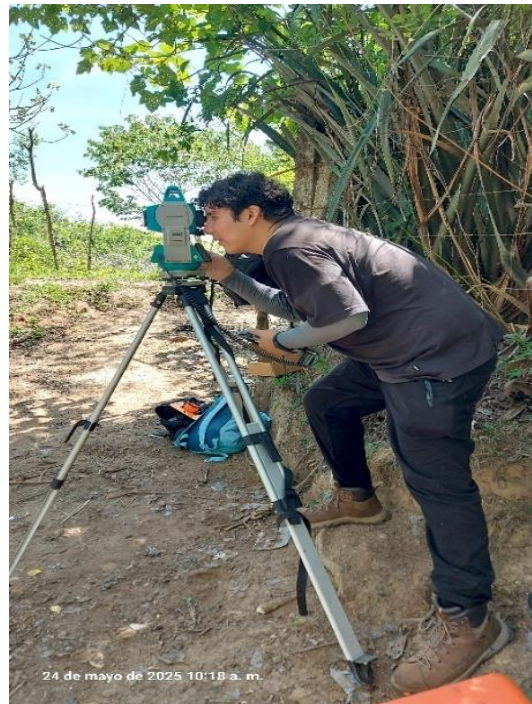
Fotografía 72. Estacionamiento en PLG3-S2.
