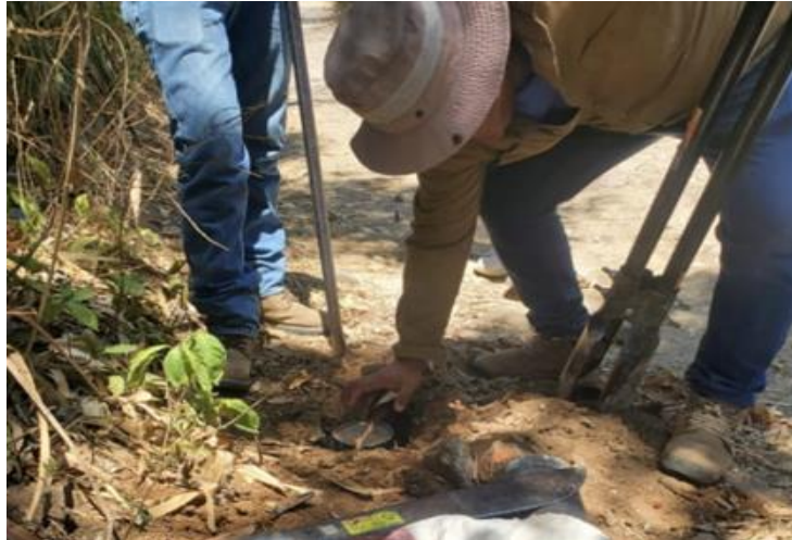
Fotografía 35. Colocación de monumento.
