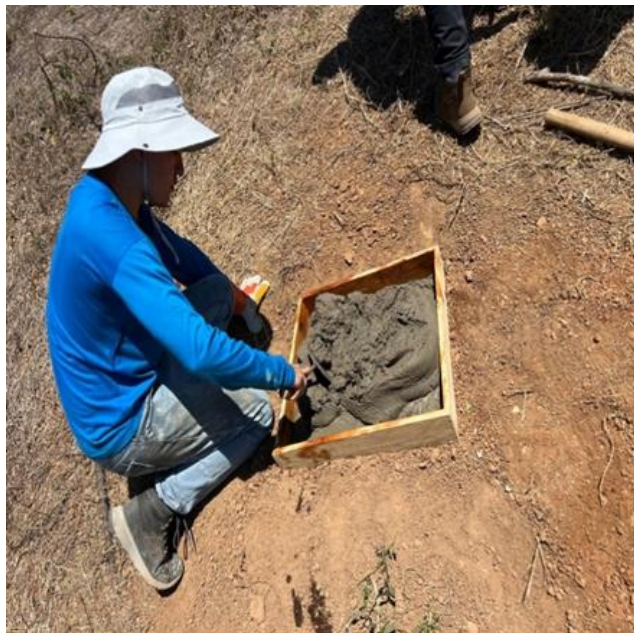
Fotografía No. 31 Colado y Nivelación de la base para el vértice geodésico
