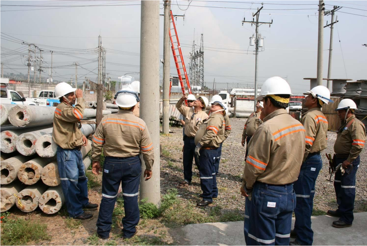
Figura 7: Inspección previa a realizar el trabajo.
