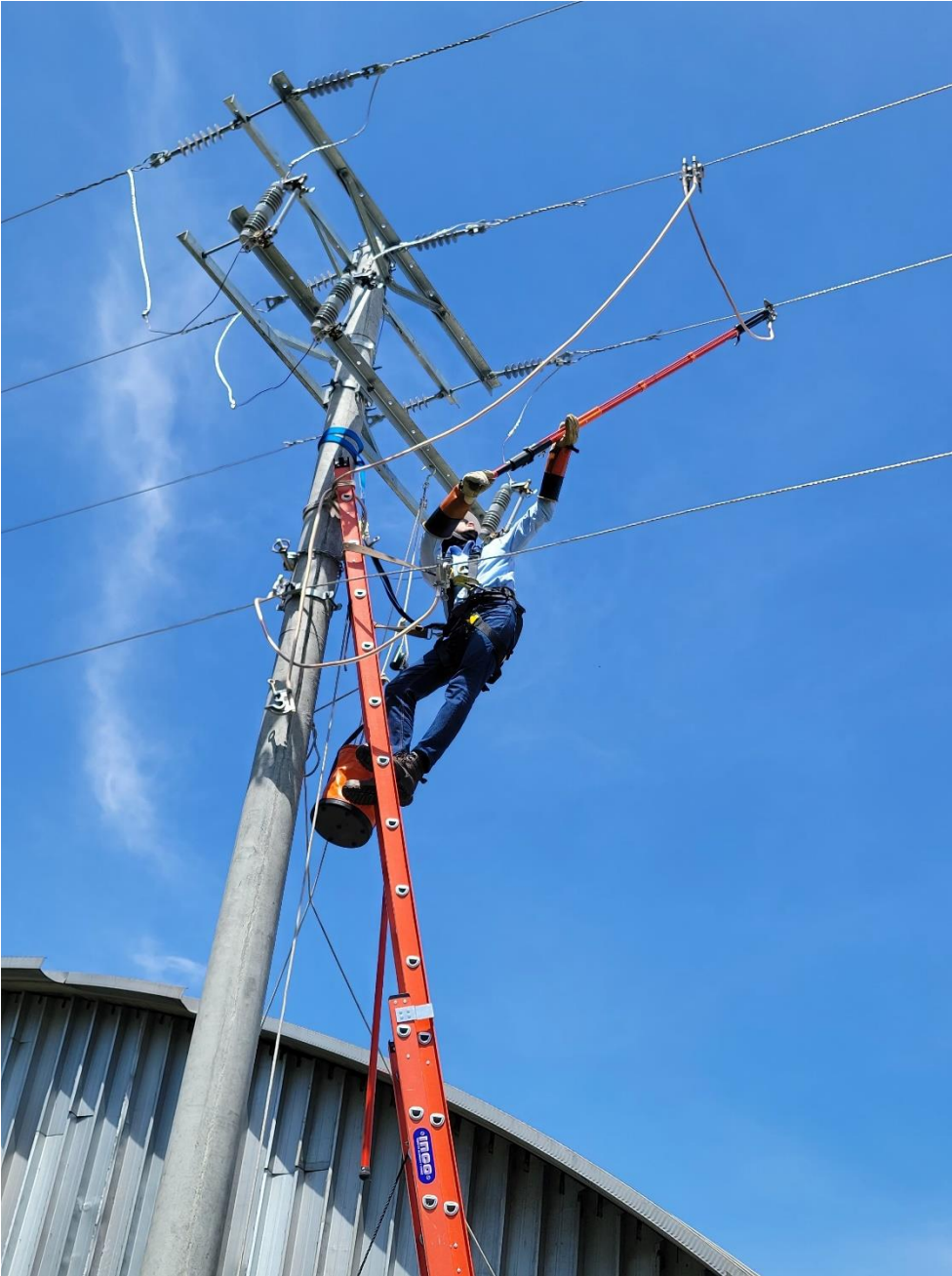
Figura 22: Colocación de la puesta a tierra (PAT).
