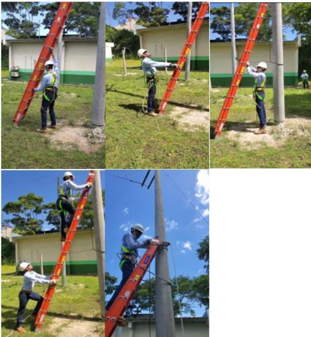
Figura 29: Aplicación de la escalera aplicando 4 a 1.
