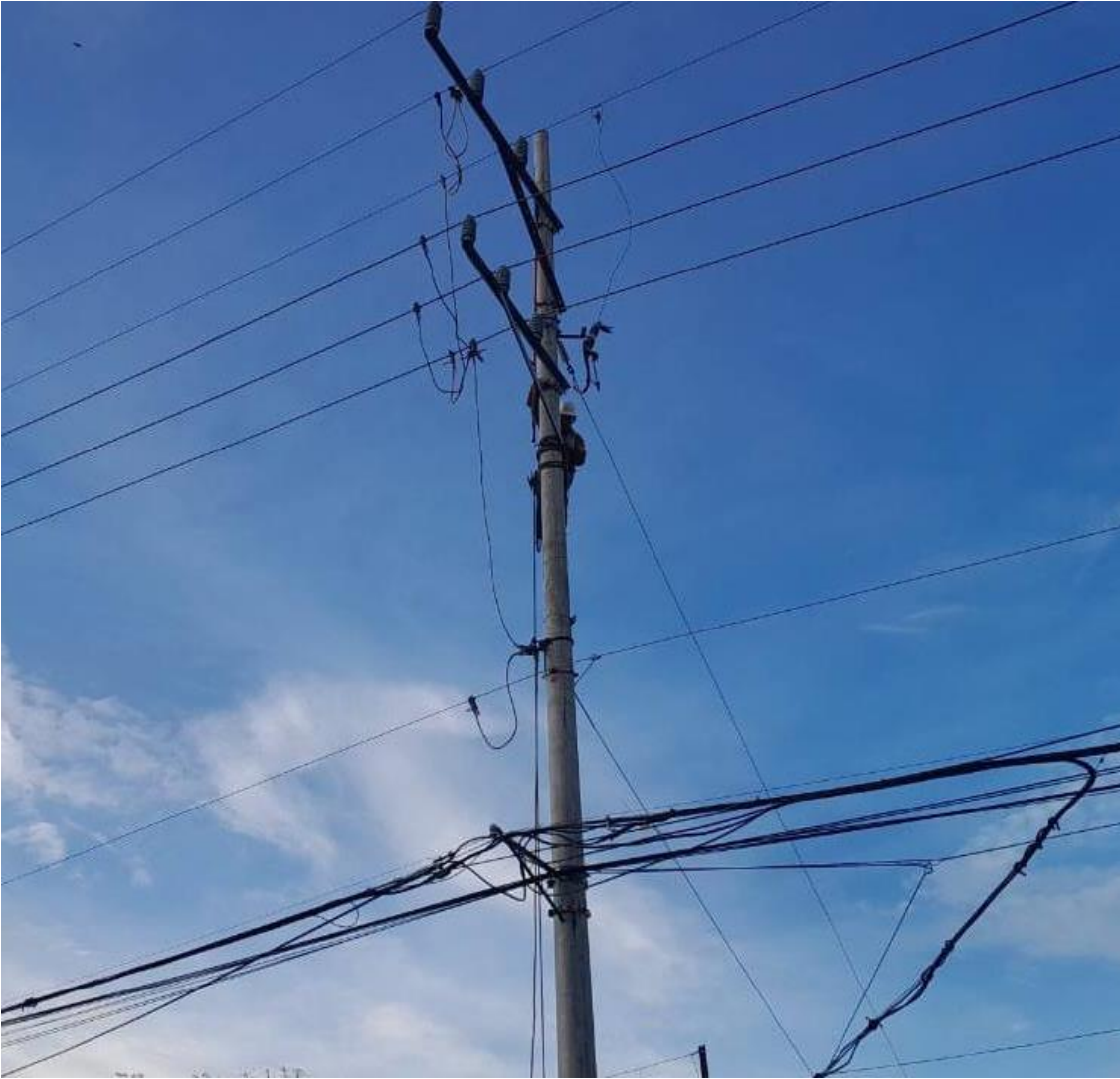
Figura 23: Puesta a tierra instalada para la intervención de la línea.
