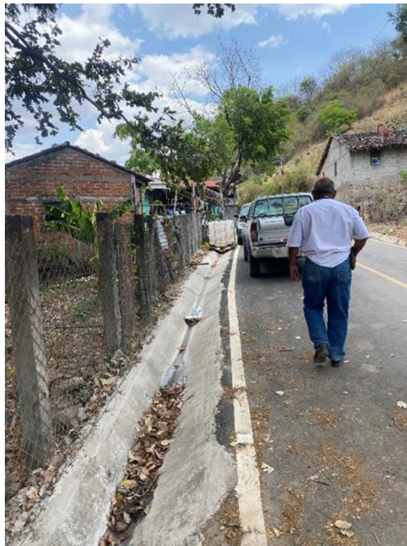
Figura A-17. Inspección de laurel en Morazán
