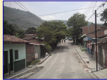
Red de Energia Electrica y de Telefonía sobre la 2da Av. Sur
