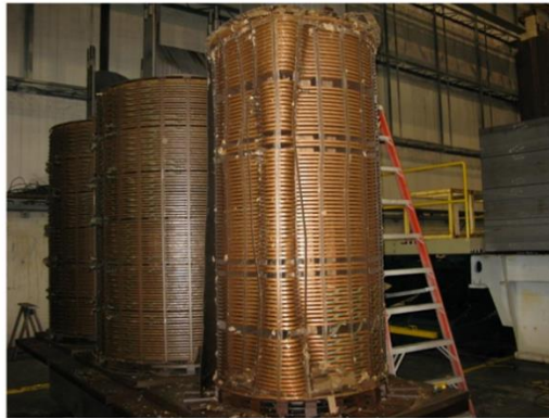
Figura 41. Caso 2 Inspección interna. Extraído de (CIGRE WG A2.53, 2020)
