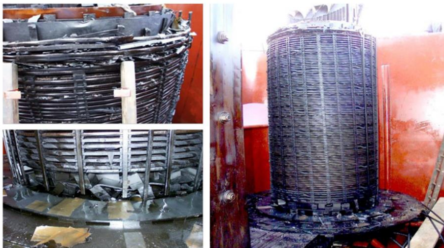
Figura 43. Caso 3 Inspección interna. Extraído de (CIGRE WG A2.53, 2020)
