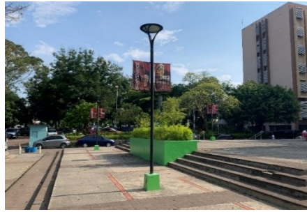
Figura 120 Luminaria tipo reflector kale Street light
