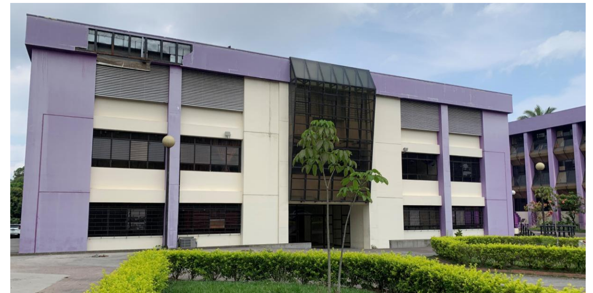
FACHADA PRINCIPAL EXISTENTE
