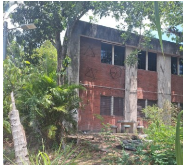
Figura 199 Mesas de Concreto ubicadas al sur de la Escuela de Biología (B)
