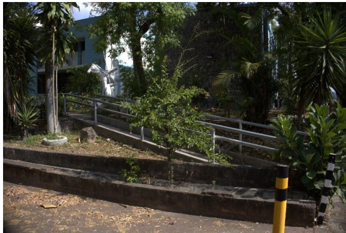
Figura 79 Rampa para movilización frente a edificio de Filosofía
