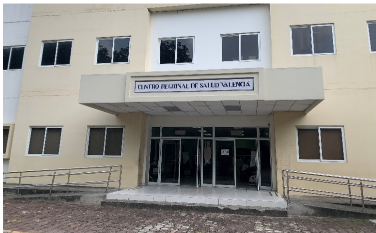
Figura 100 Rampa de acceso a edificio de centro nacional de salud valencia
