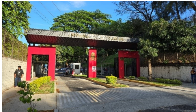
Figura 45 Portón 2 de acceso vehicular y peatonal Facultad de Ciencias Económicas
