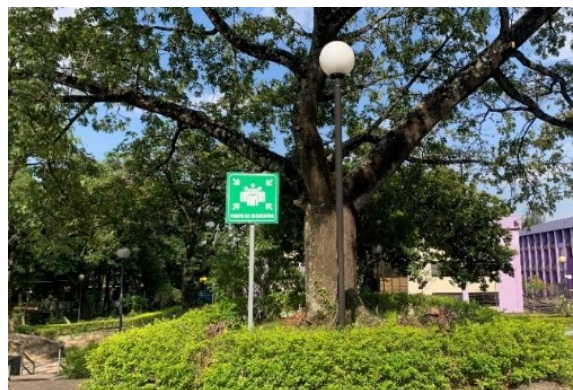
Figura 118 Luminaria tipo farol globo
