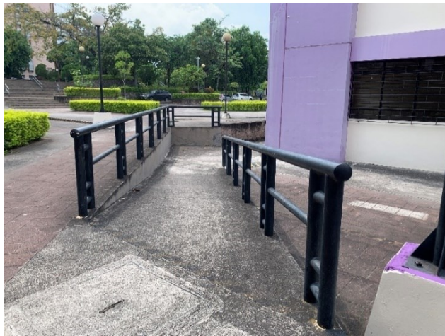
Figura 128 Rampa para acceder a edificio clínicas odontología
