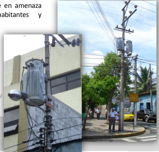
Foto N° 2.29: Vista de transformadores de energía eléctrica.
