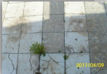
Foto N° 2.74: Presencia de ladrillo de piso de en el segundo nivel a diferencia del nivel 1 Fuente: Sonia González.
