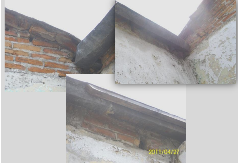
Foto N° 2.114: Detalle del canal parapetado y sus bajadas de agua. Detalle del techo, una de sus cumbreras, sobrantes de tejas y huecos donde se apoyaban las tijeras. Fuente: Sonia González.
