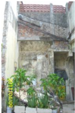
VISTAS HACIA ESCALERAS; ESTADO ACTUAL.
