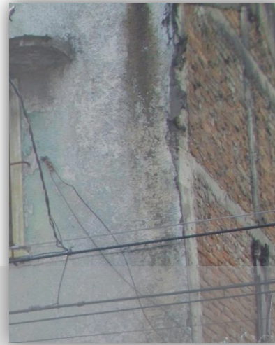
Foto N° 2.100: Detalle de Fisura y Desprendimiento. Fuente: Sonia González.
