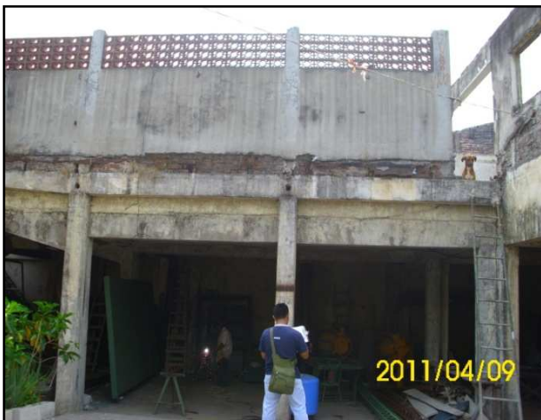
Imagen 2: Vista sobre el eje B del edificio, en esta vista podemos observar de igual forma el comportamiento original y la posición donde debió estar el sistema de losa en sus inicios y que con la estructuración y cambio de uso que sufrió se cambio de posición y también se desarrollaron cambios en las vigas a fin de darle una estructuración seguramente pensando en que el cambio de losa afectaría los elementos verticales sismo resistentes(columnas)
