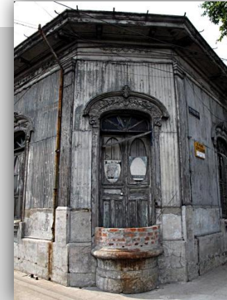
Foto N° 2.92: Utilización de lámina con estructura de madera en casas aledañas a Ex Colegio Celestino Fuente: Elaboración Propia
