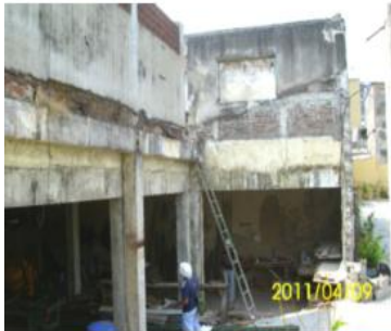
VISTAS HACIA SERVICIOS SANITARIOS; ESTADO ACTUAL.
