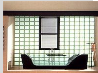
Foto N° 2.64: Uso de ladrillo de vidrio en paredes Fuente: http://www.aki.com.ve/
