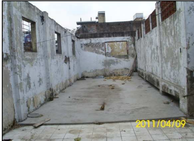
Imagen 1 En esta imagen podemos observar que el nivel original de la vivienda estaba sobre la viga que actualmente sirve para apoyar las paredes del eje C, las cuales aparecen con la celosía de barro, pudiendo observarse también las dimensiones de dichos elementos.
