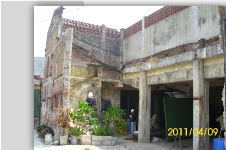
Foto N° 2.70: Elevación poniente. Parte de esta pared fue demolida, por lo que se puede observar el interior del primer nivel de la casa. Fuente: Sonia González.
