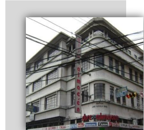
Foto N° 2.68: El edificio de Disco Almacén es uno de los edificios representativos del Stream Line en el país. Fuente: http://www.skyscrapercity.com
