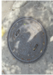
Foto N° 2.30: Pozo Registro de Aguas Negras Fuente: Elaboración Propia
