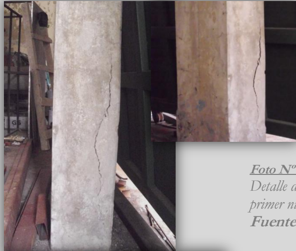
Foto N° 2.117: Detalle de fisuras en columnas y vigas, segundo nivel. Fuente: Sonia González.
