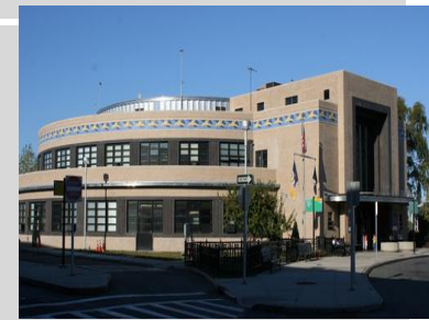
Foto N° 2.62: La Guardia Airport's Marine Air Terminal. Orientación horizontal es una de las características del Stream line
