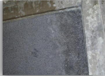
Foto N° 2.72: Superficie hormigonada de la losa. Fuente: Sonia González.
