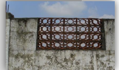
Foto N° 2.76: Baldosas de arcilla con hueco en lugar de ventanas en el nivel 2. Fuente: Sonia González.
