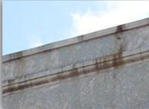
Foto N° 2.102: Detalle de Mobo sobre elementos de ventanas. Fuente: Sonia González.
