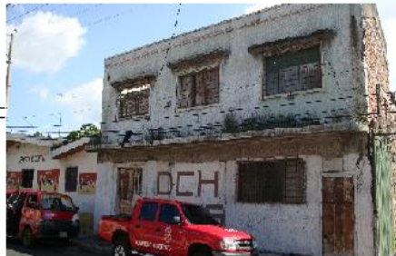
VISTAS HACIA FACHADA; ESTADO ACTUAL.
