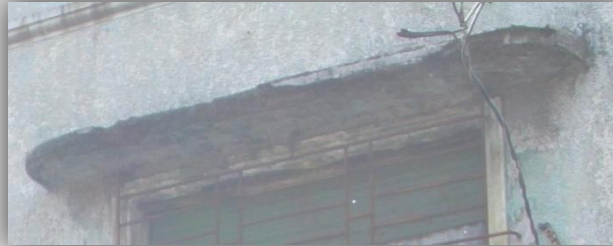
Foto N° 2.102: Detalle de Mobo sobre elementos de ventanas. Fuente: Sonia González.
