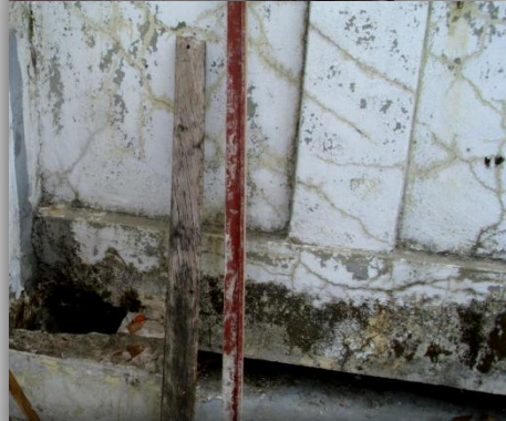
Foto N° 2.117: Detalle de fisuras en columnas y vigas, segundo nivel. Fuente: Sonia González.
