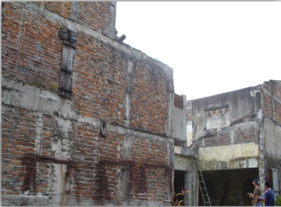
Foto N° 2.97: Sistema constructivo mixto, compuesto de ladrillo de obra y concreto armado. Fuente: Sonia González.
