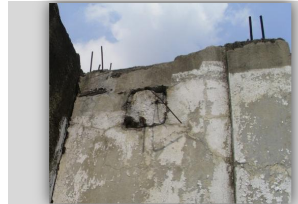
Foto N° 2.89: Utilización de acero en las columnas y en la construcción de paredes. Fuente: Sonia González.
