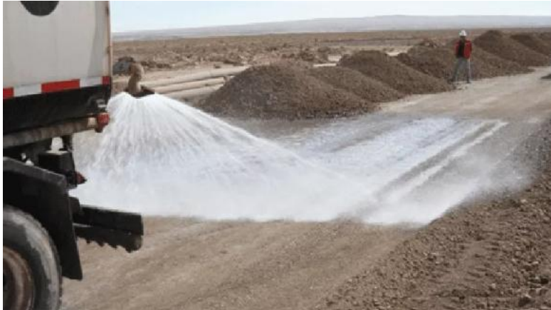
Figura 36. Humectación en proyecto con pipa.
