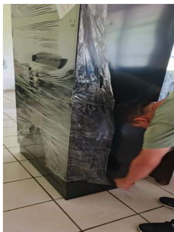
Figura 18. Apoyo en el traslado e instalación de equipo nuevo para oficinas de la Gerencia de Transferencia Tecnológica y Extensión.
