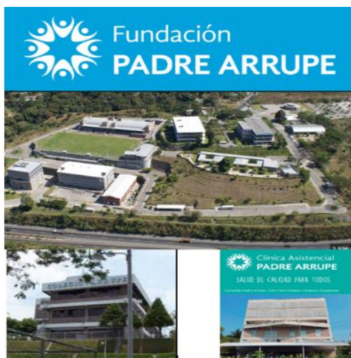
Figura 6 - Fachada de FUPAES
