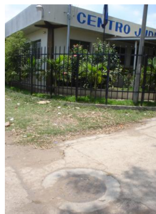
Fotografía No. 34 Pozo colector de aguas negras
