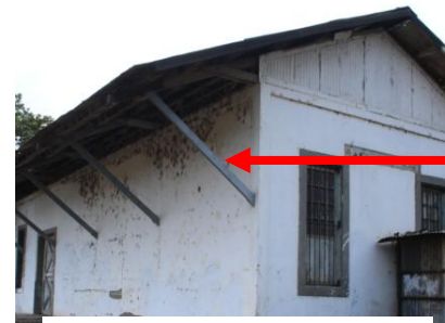
Fotografía No. 00 Elemento de sujeción de aleros en estación
