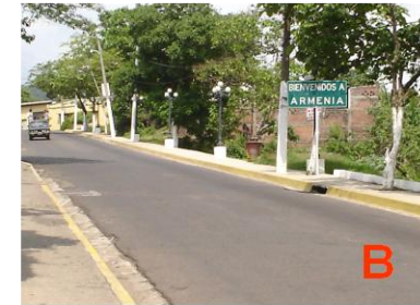
Fotografía No. 00 CALLE DE ACCESO hasta el área urbana de la ciudad.
