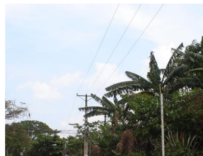
Fotografía No. 35 Líneas primarias de energía eléctrica, cercanas al terreno
