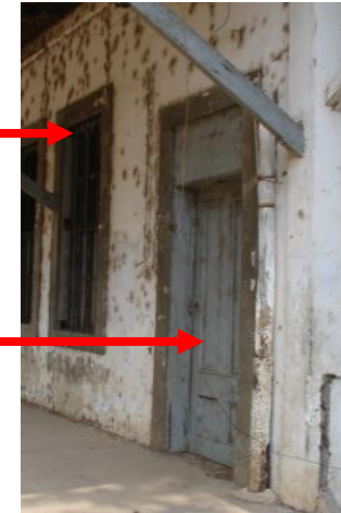
Fotografía No. 00 Puerta y ventana de estación
