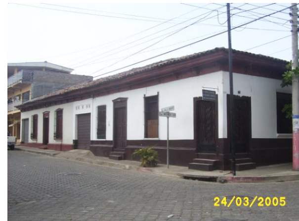
Fotografía No. 15 Clínica privada Armenia.
