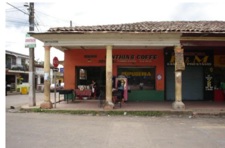
Fotografía No. 23 Vista de portal sobre intersección de Avenida 3 de Abril y 1ª. Calle Oriente
