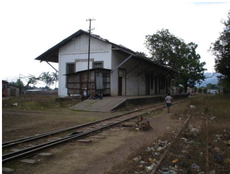
Fotografía No.70 Vista de elevación poniente de la Estación
