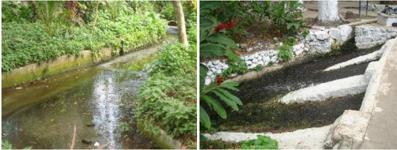
Imagen 38. Canal de descarga y desagüe
