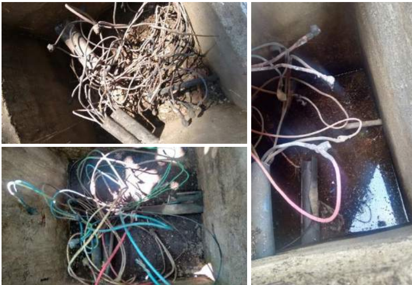
Imagen 43. Estado actual sistema de pozos de visita
