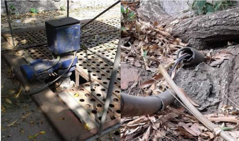
Imagen 49. Estado actual de la plata de tratamiento de aguas residuales
