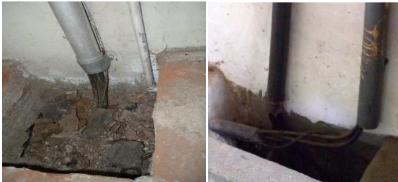
Imagen 53. Exposición de cables en panel de control del sistema de bombeo
