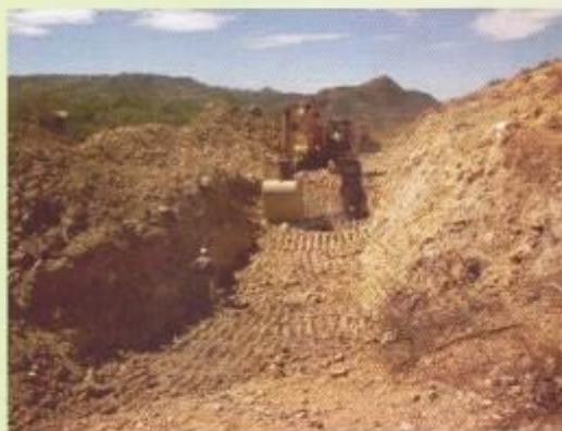
Construcción de drenajes en calle de acceso
