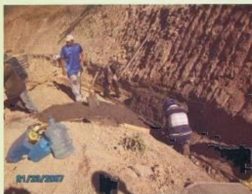
Excavación de terrazas
