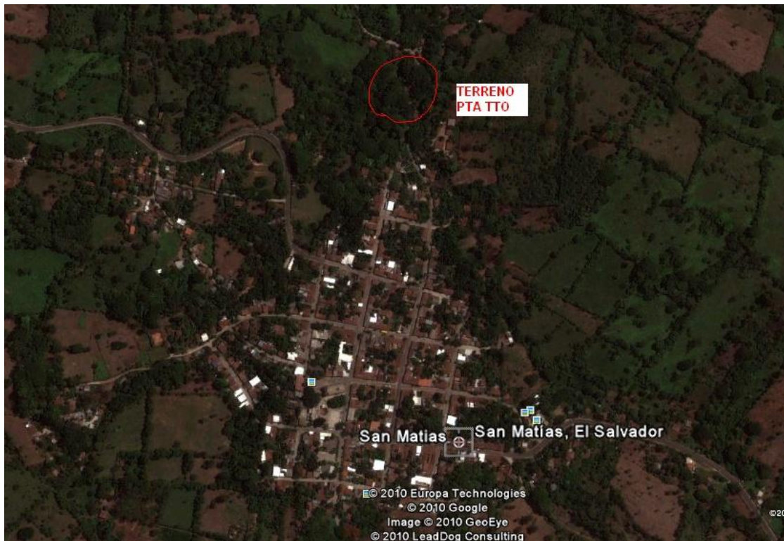
Figura 6.1 Ubicación del terreno propuesto para la construcción de la planta de tratamiento de aguas residuales domesticas.
