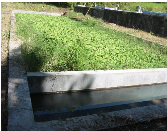
Figura 2.23 Tratamiento terciario eliminación de nutrientes
