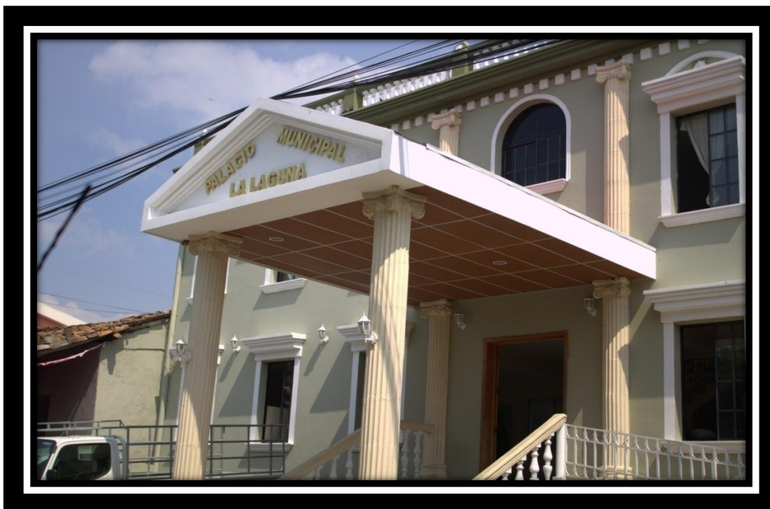
FACHADA DE LA ALCALDIA DEL MUNICIPIO. Fecha 12/04/2018
