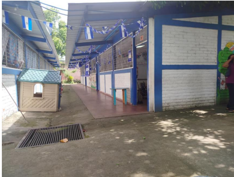
Fotografía 13: Infraestructura del Complejo Educativo Griselda Zeledón.
